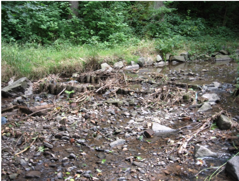
Foto 1: Gablenzbach mit Sohlrampe im Abschnitt 38 (LFULG 2017g)
