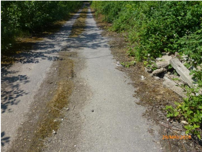
Foto 47: Forststraße Zehmen mit einzelnen Bauschuttverkipungen im Randbereich
