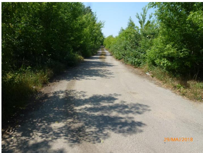
Foto 60: Forststraße in Zehmen, Standort für die Erstaufforstung nach Rückbau der Straße
