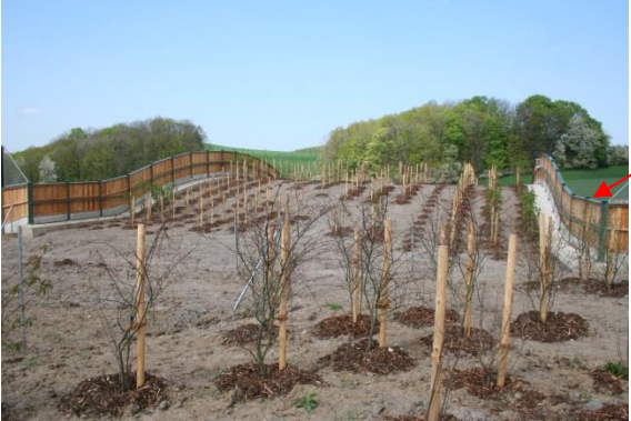
Beispiel für Faunabrücke mit 2,00 m hohen Blend- und Irritationsschutzwänden auf beiden Seiten des BW
