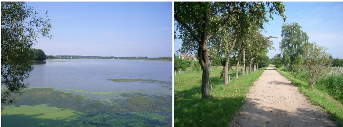
Foto 30: Wasserfläche und begehbare Damm am Großen Teich Eschefeld
