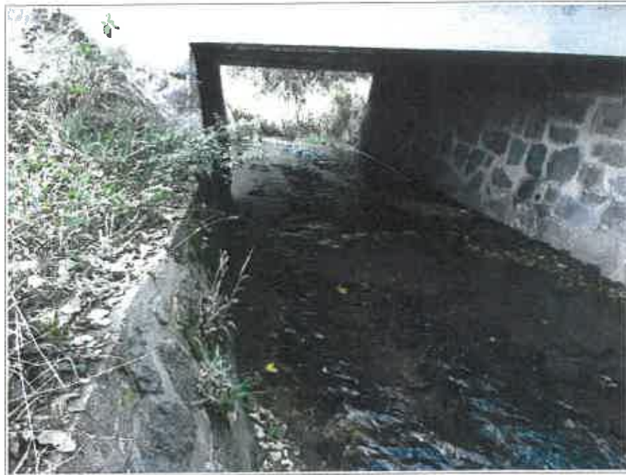
Abb. 5 Oberstromseite der Brücke mit Blick auf die Widerlager und die Gewässersohle. Im Vordergrund ist ein Teil der Unterwasservegetation sichtbar (Quellmoos).
