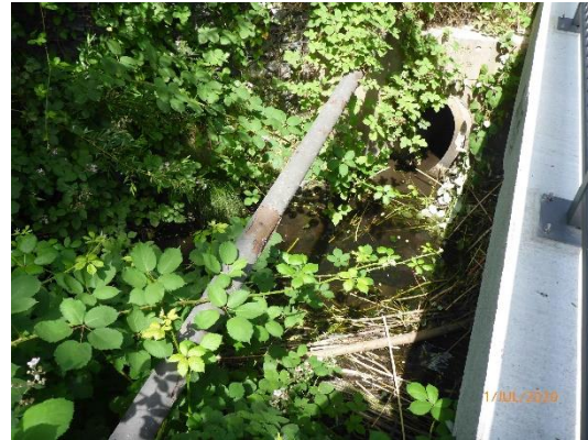
Foto 4: Einleitstelle im Bereich der Straßenbrücke (Industriestraße)
