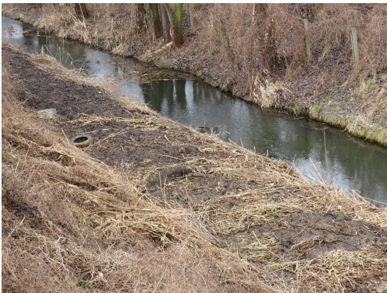
Foto 7: linkes Ufer des Langen Grabens mit Baggergut (Schlamm, Pflanzenmaterial, Autoreifen) (22.02.2017)
