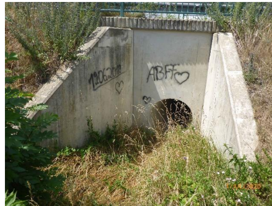
Foto 11: Langer Graben, Gewässerabschnitt 63 (bestehendes Brückenbauwerk Elbgaustraße)
