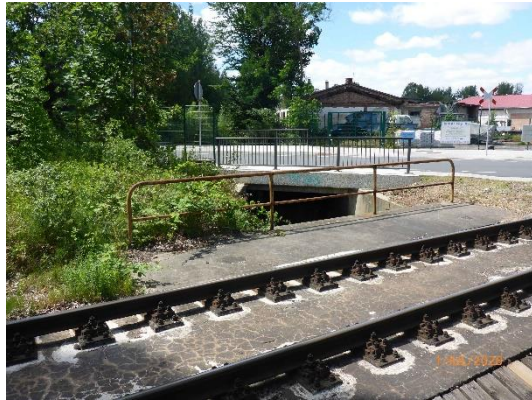
Foto 3: Straßenbrücke (Industriestraße) und Eisenbahnbrücke über den Lockwitzbach
