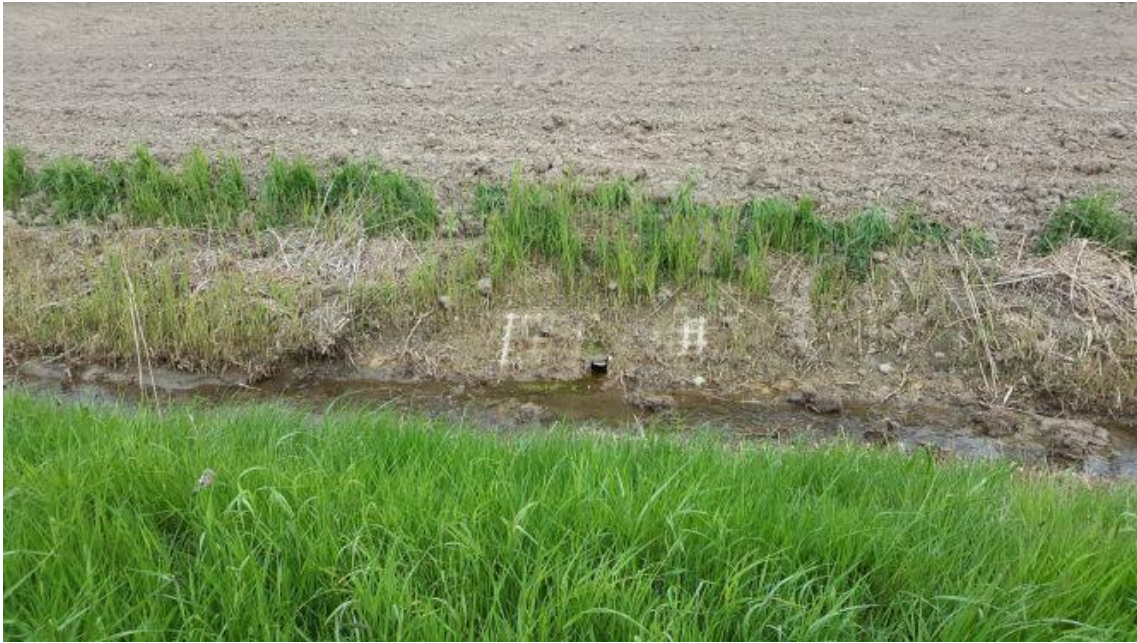
Foto 2: Entwässerung eines funktionstüchtigen Sammlers in den östlichen Graben (Aufnahmedatum: 08.05.2017)
