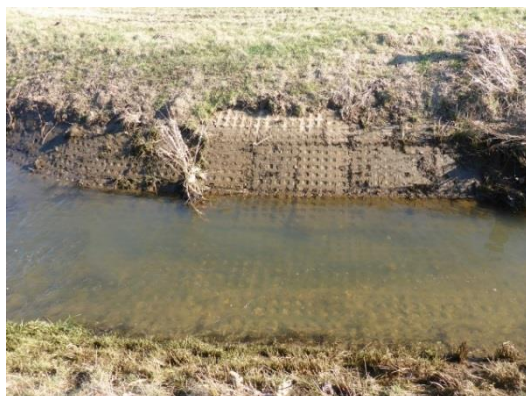
Foto 10: links: aktueller Gewässerverbau mit Rasengittersteinen im Bachabschnitt 20 verhindert Wachstum von Makrophyten und sonstiger gewässerbegleitender Vegetation, rechts: Substratauflage auf Rasengittersteinen ermöglicht Wachstum in Bachabschnitt 20
