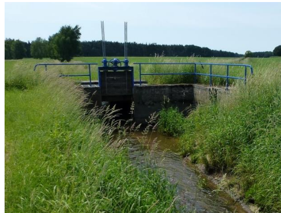
Foto 8: Schützenwehr am Schönfelder Dorfbach, Gewässerabschnitt 19: links: halbverschlossenes Schütz; rechts: geöffnetes Schütz
