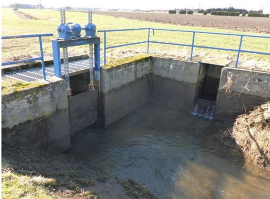
Foto 8: Schützenwehr am Schönfelder Dorfbach, Gewässerabschnitt 19: links: halbverschlossenes Schütz; rechts: geöffnetes Schütz
