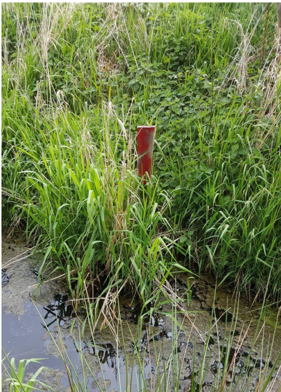
Foto 3: Entwässerung eines nicht funktionstüchtigen Sammlers in den Röhrichtteichgraben (Aufnahmedatum: 08.05.2017)
