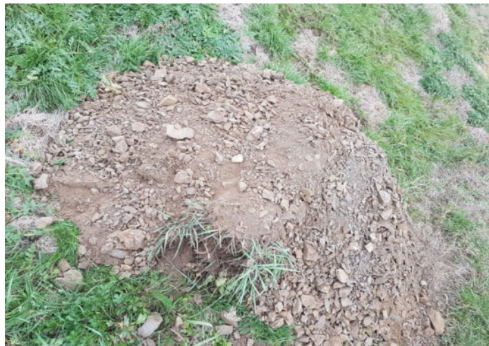
Foto 8: Aushub - Grauwackezersatz (0,10-0,60 m)
