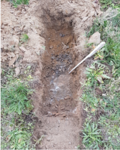
Foto 13: Schurf SG 6/19 (Tiefe bis 0,60 m)
