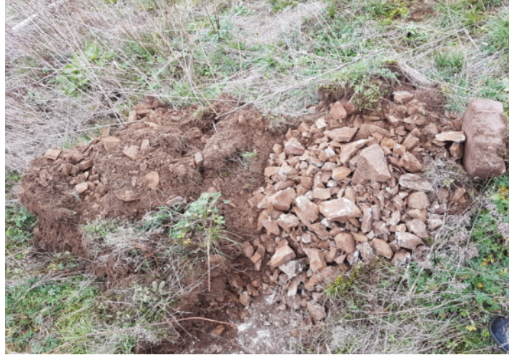
Foto 18: Aushub - Grauwackezersatz (0,05-0,30 m)
