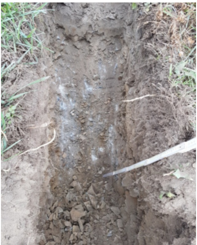
Foto 3: Schurf SG 2/19 (Tiefe bis 0,80 m)
