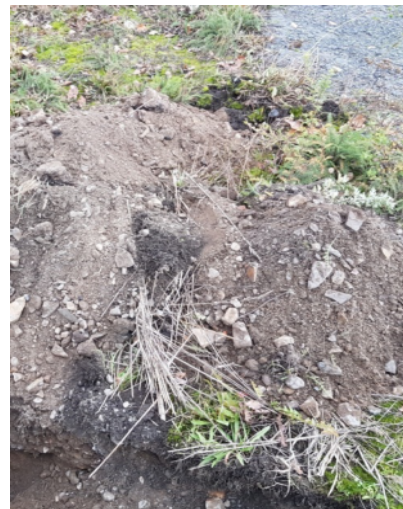
Foto 20: Aushub - Auffüllung (0,00-0,45 m)
