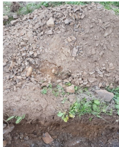
Foto 12: Aushub - Grauwackezersatz (0,05-0,40 m)
