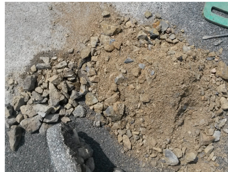
Foto 2: Aushubmaterial Tragschicht, gleisschotterartig (links), Tragschicht (rechts)
