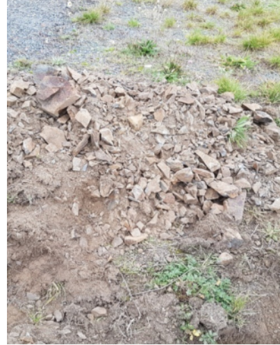
Foto 6: Aushub - Grauwackezersatz (0,10-0,40 m)
