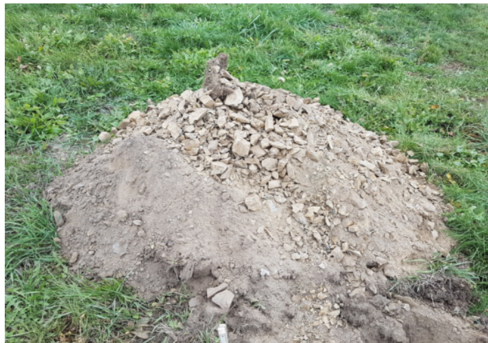
Foto 4: Aushub - Hanglehm (0,05-0,30 m), Grauwackezersatz (0,30-0,80 m)
