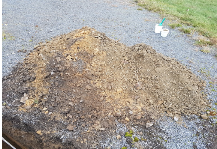
Foto 2: Aushub - Schotter (0,00-0,45 m), Sand (0,45-0,70 m), Grauwackezersatz (0,70-1,30 m)
