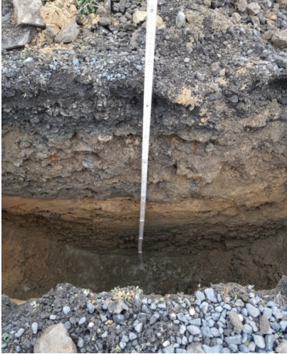
Foto 1: Schurf SG 1/19 (Tiefe bis 1,30 m)
