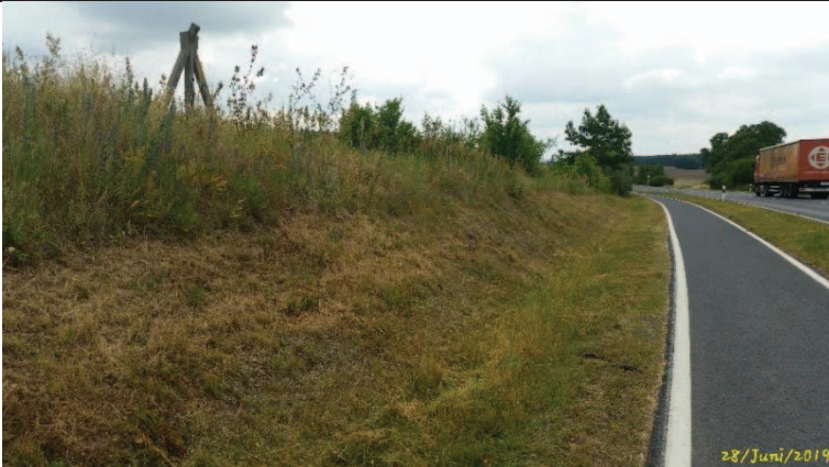
Abb. 8: südwestexponierte Straßenböschung nordöstlich der bestehenden B 98 mit parallel zur Straße verlaufendem Radweg. Nachweisort von adulten und juvenilen Zauneidechsen sowie Blindschleichen.
