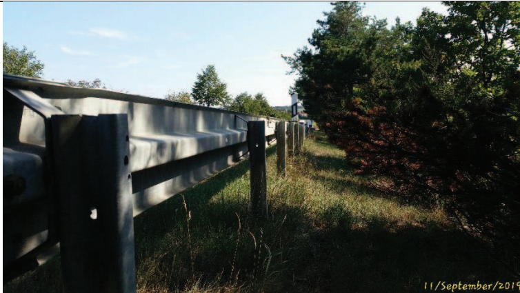
Abb. 1: Straßenböschungen (Schwerpunktbereich West) südlich der bestehenden B 98 in Höhe des Betonwerkes. Nachweisort adulter und juveniler Zauneidechsen.
