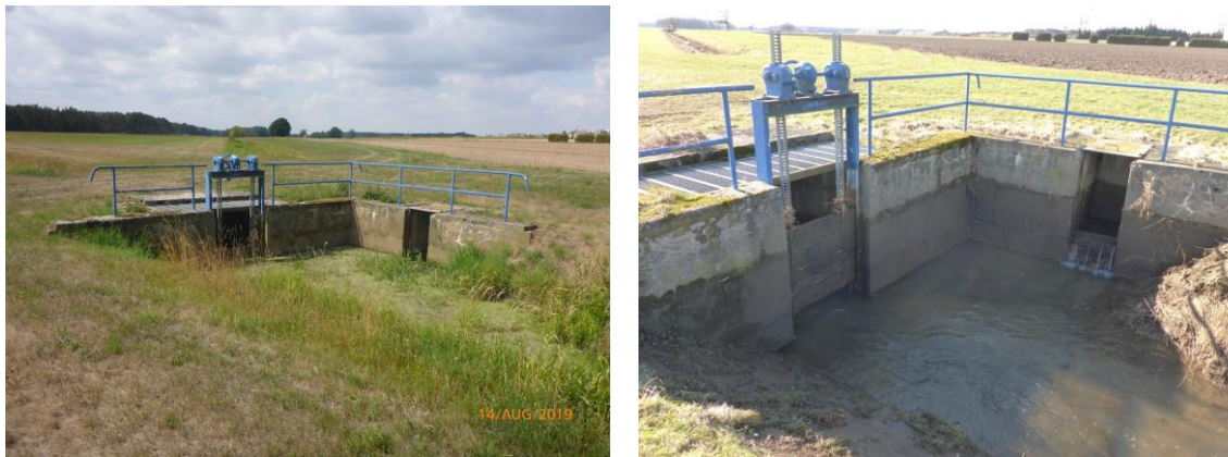
Foto 31: Wehranlage des Schönfelder Dorfbaches auf der Schafwiese
