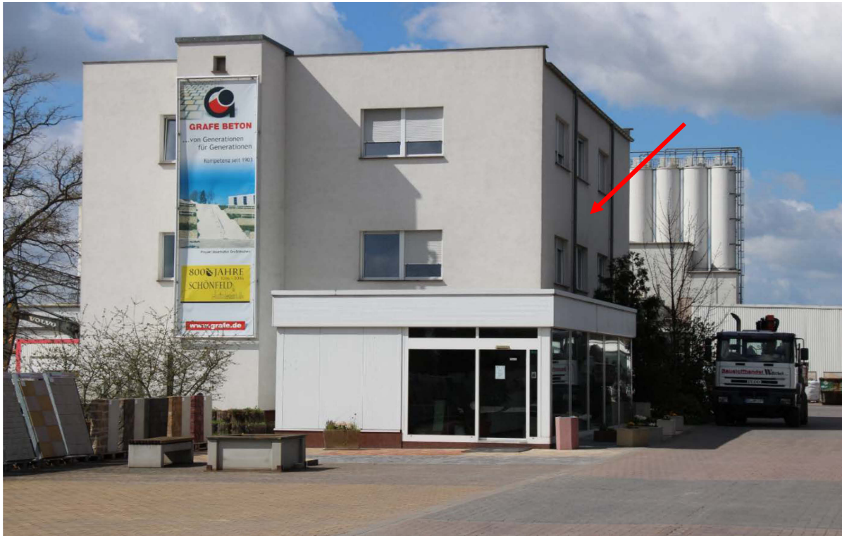
IO 5, Großenhainer Straße 29: NO-Fassade (Pfeil)
