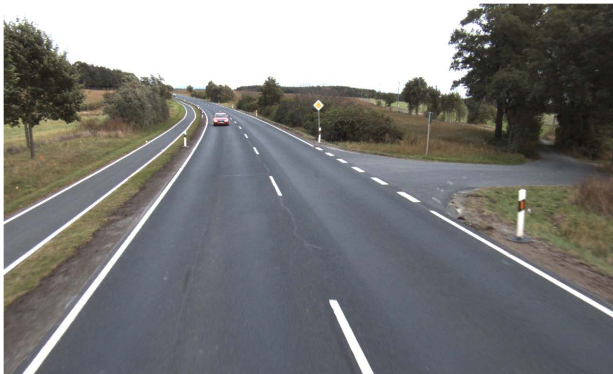
Bild 4: Zufahrt 2 – Einmündung zur Kienmühle
