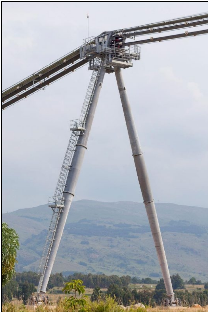
Abbildung 6: Typische Stütze mit A-Rahmen (illustrativer Charakter; Doppelmayr, 2023)
