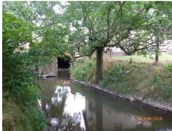
Foto 5: links: Uferbefestigung des Löbauer Wassers im Bereich der S 112; rechts: befestigter Auslauf des Mühlgrabens
