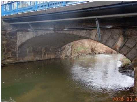
Foto 16: Bestandsbrückenbauwerk der S 112 über das Löbauer Wasser ohne fischottergerechte Bermen (März 2020)
