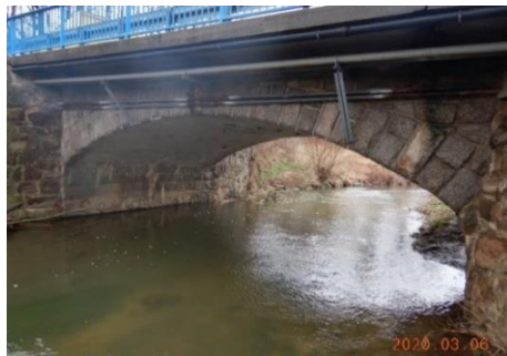
Foto 2: Bestandsbrücke der S 112 über das Löbauer Wasser ohne fischottergerechte Bermen (März 2020)
