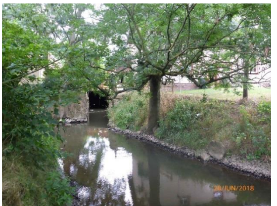
Foto 5: links: Uferbefestigung des Löbauer Wassers im Bereich der S 112; rechts: befestigter Auslauf des Mühlgrabens
