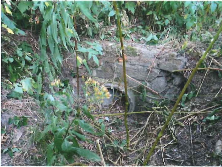
Foto 1: Entwässerung der Bestandsstraße in die Flöha
