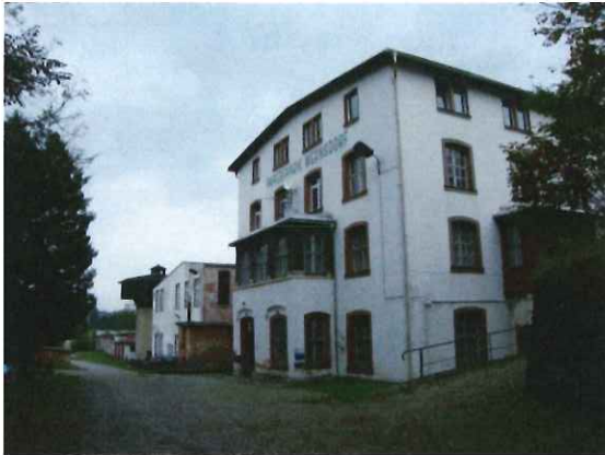
Foto 7: Gebäudekomplex Papierfabrik Wernsdorf zum Teil genutzt/ bewohnt
