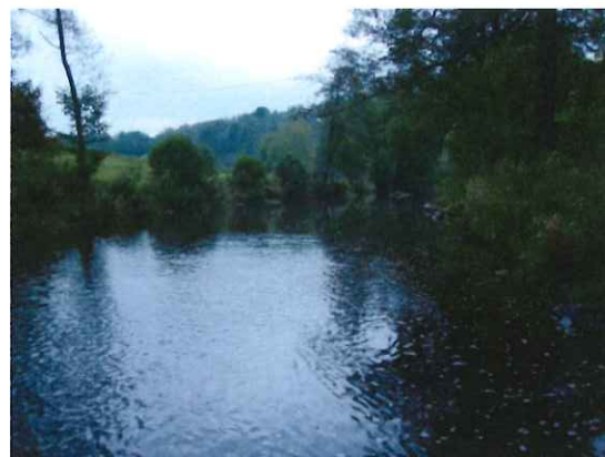
Foto 2: rechts unterhalb der Brückenquerung, schon mit leichter Rückstauwirkung
