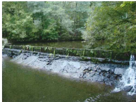
Foto 6: Wehranlage an der Ausleitung Mühl- graben Nennigmühle
