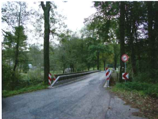
Foto 8: BW 8 über die Flöha an der ehemaligen Papierfabrik Wernsdorf Blick von West nach Ost
