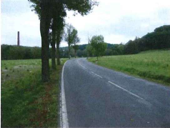
Foto 13: S 223 zwischen Nennigmühle und Brückenquerung Papierfabrik Wernsdorf
