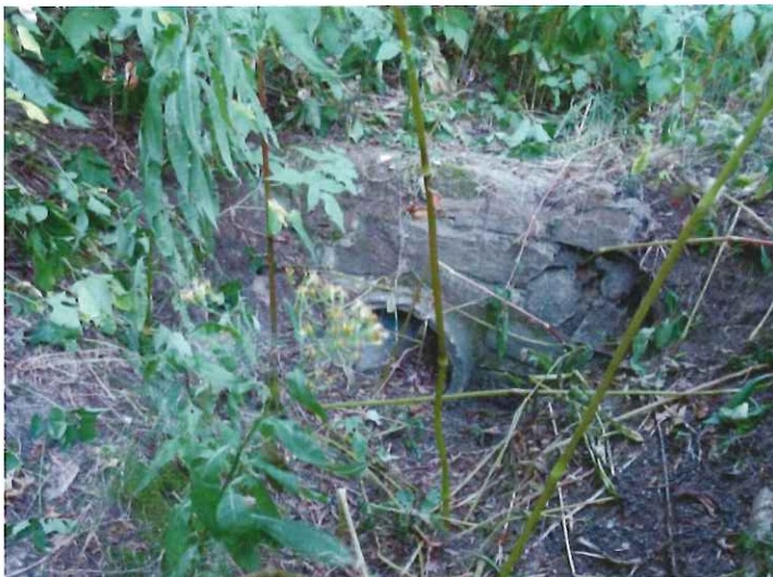
Foto 1: Entwässerung der Bestandsstraße in die Flöha
