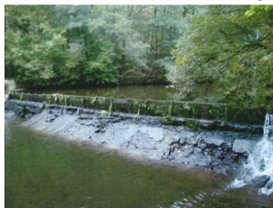
Foto 4: Wehranlage an der Ausleitung Mühl- graben Nennigmühle
