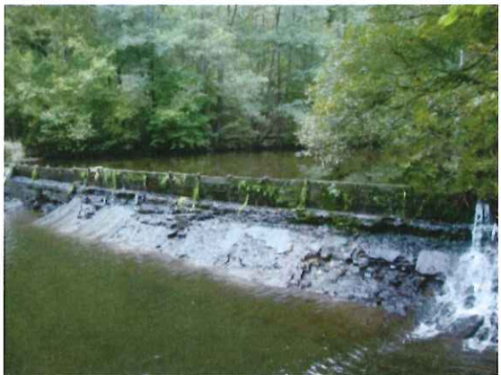
Foto 7: Wehranlage an der Ausleitung Mühl- graben Nennigmühle
