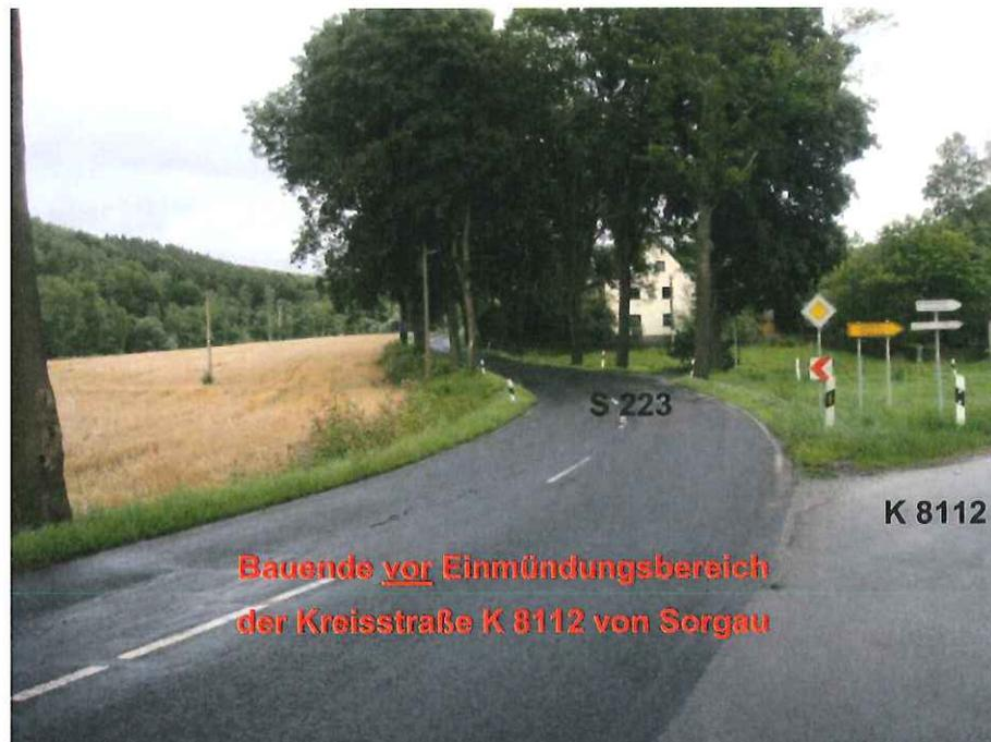
Die Straße ist zurzeit mit Asphaltbefestigung versehen. Sie weist variable Fahrbahnbreiten von ca. 5,50 m bis ca. 6,50 m auf. Die Fahrbahnen selbst sind z. T. durch Ebenheitsmängel in Längs- und Querrichtung, Tragfähigkeitsschäden und Setzungen gekennzeichnet.
