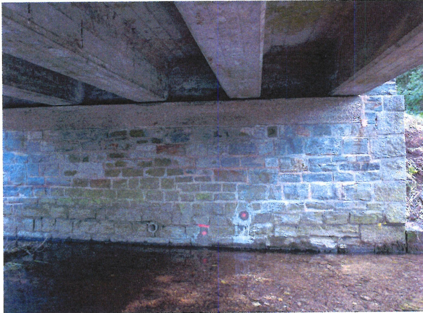
Widerlageransicht mit Bohransatzpunkten KB 3, KB 4
