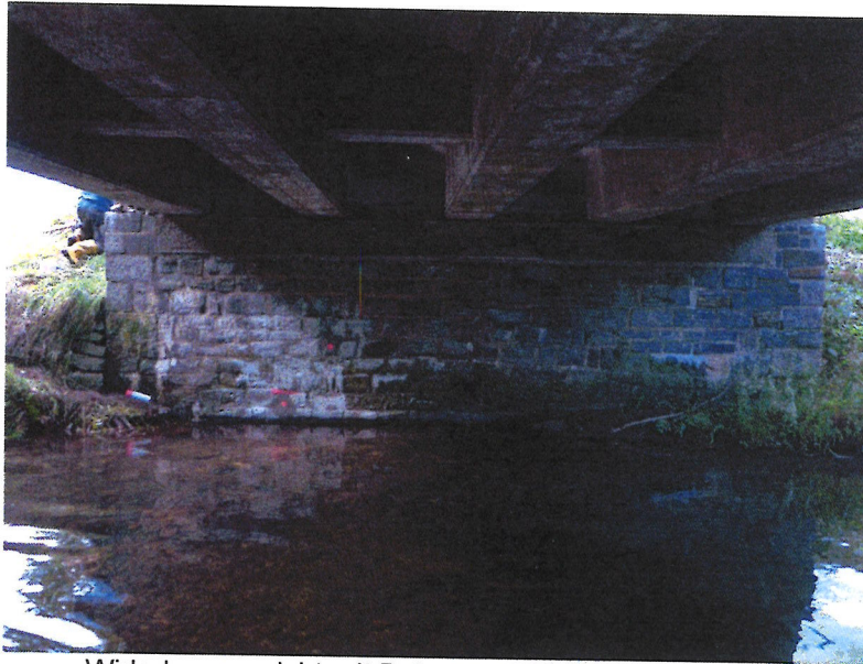
Widerlageransicht mit Bohransatzpunkten KB 1, KB 2
