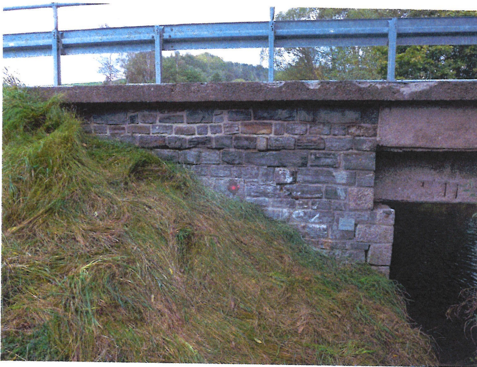
Flügelmauer Seite Heidersdorf (unterstrom) mit Bohransatzpunkt KB 5
