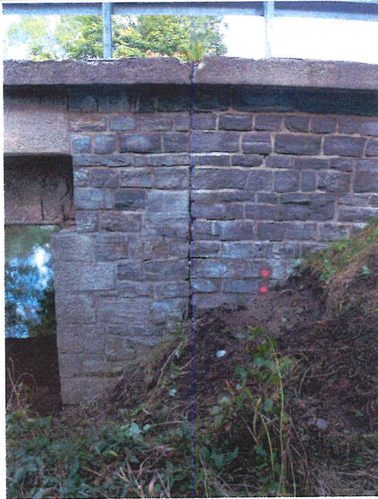
Flügelmauer Seite Neuhausen (unterstrom) mit Bohransatzpunkten KB 7, KB 8
