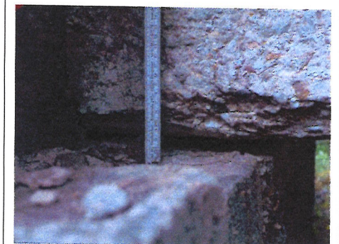
Detail Auflagerbank, Abstand bis zum Balken: 2 cm
