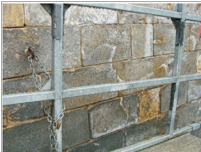
Foto 3: Ansicht Mauerwerk mit Abplatzungen, offenen Fugen und Salzablagerungen
