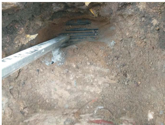
Bild 2: Schurf 23 mit unmittelbar an Wand anliegendem Leitungsbestand
