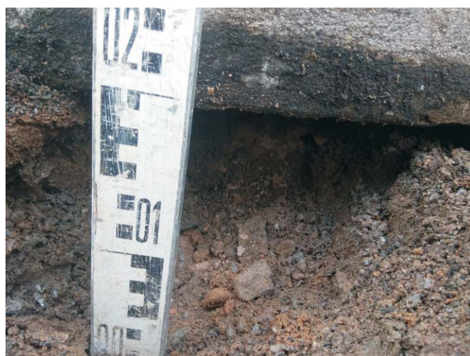
Bild 2: Schurf 22 mit erkennbarer Gründungssohle (0,04 m u. OK Fußweg)
