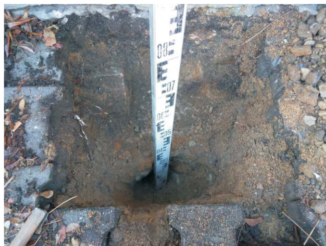
Bild 2: Schurf 10 mit erkennbarer Gründungssohle
