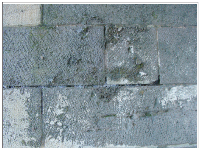
Foto 6: Detail WL Elsterwerda mit schadhaften Fugen sowie Krustenbildungen und Spontanvegetation
