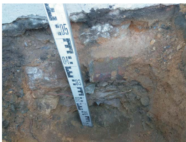
Bild 2: Schurf 11-2 mit erkennbarer Gründungssohle
