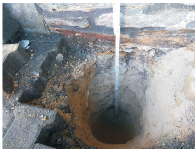
Bild 2: Schurf 2 mit erkennbarer Gründungssohle
