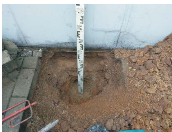
Bild 2: Schurf 19a mit erkennbarer Gründungssohle
