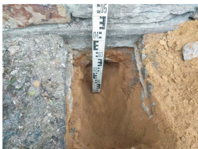
Bild 2: Schurf 33 mit erkennbarer Gründungssohle
