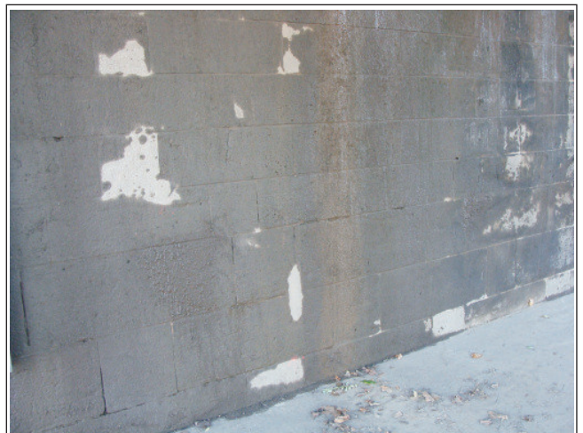
Foto 4: Detail WL Dresden mit Nässe und Feuchte sowie Fahnenbildungen und Verfärbungen
