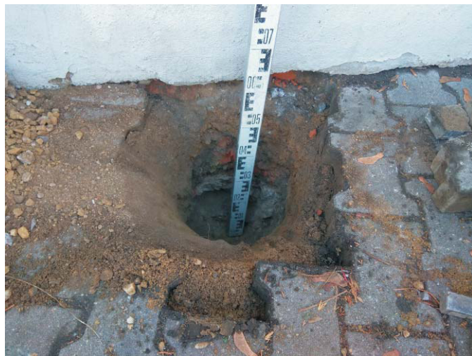
Bild 2: Schurf 11-1 mit erkennbarer Gründungssohle
