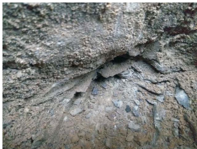
Bild 2: Schurf 9 mit erkennbarer Gründungssohle und unterlagerndem Pläner
