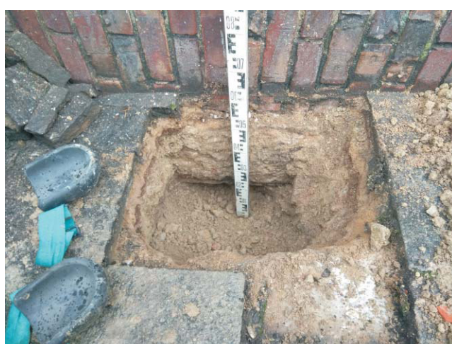
Bild 2: Schurf 20a mit erkennbarer Gründungssohle
