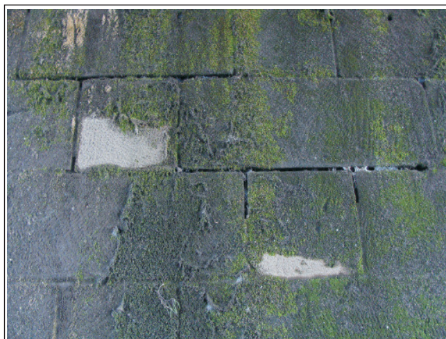
Foto 5: Detail WL Elsterwerda mit offenen Fugen und ausgeprägter Spontanvegetation
