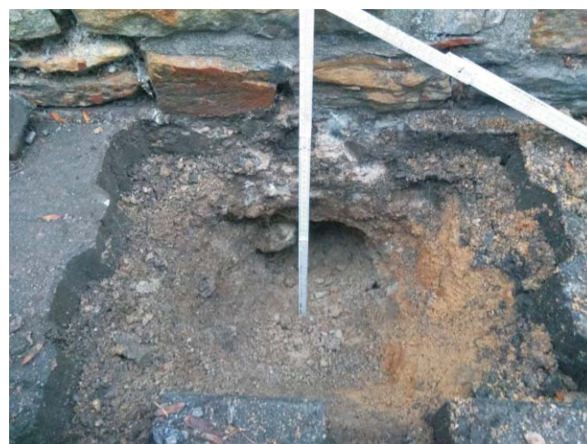
Bild 2: Schurf 4 mit erkennbarer Gründungssohle
