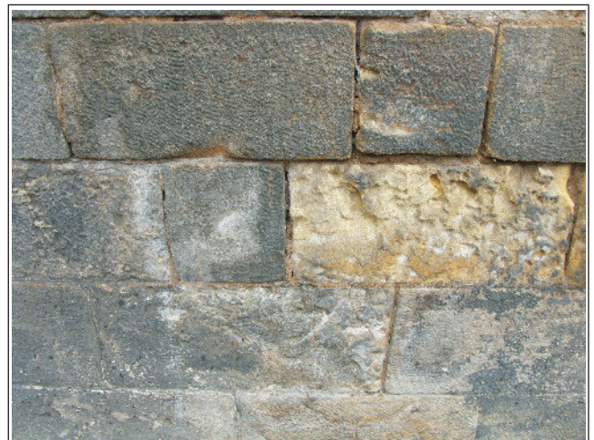
Foto 4: Ansicht Mauerwerk mit Steinausbrüchen und offenen Fugen
