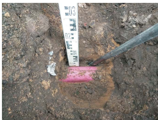
Bild 2: Schurf 17 mit Leitung (Stadtbeleuchtung) und Schlitzsonde zur Ermittlung UK Beton-Fundament
