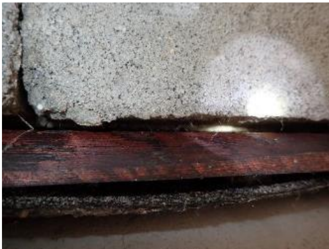
Abb. 10/ 11: Verfugte Deckenspalten
