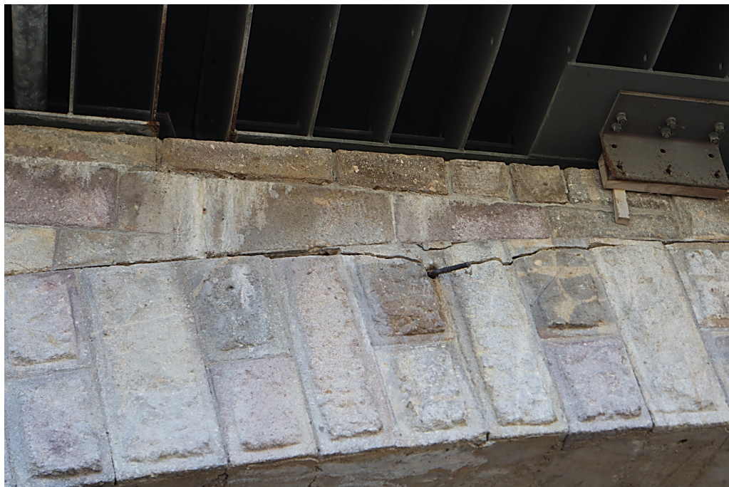
Bild 4: Riss im Gewölbe der Brücke stirnseitig oberstrom, potentielle Fledermausquartiere
