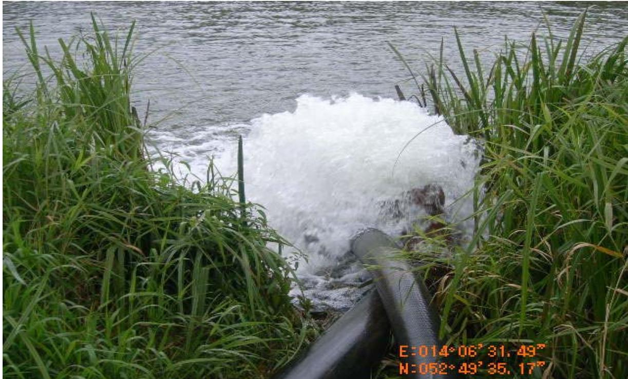
Abb. 4: Direkte Einleitung des Grundwassers in Oberflächengewässer
