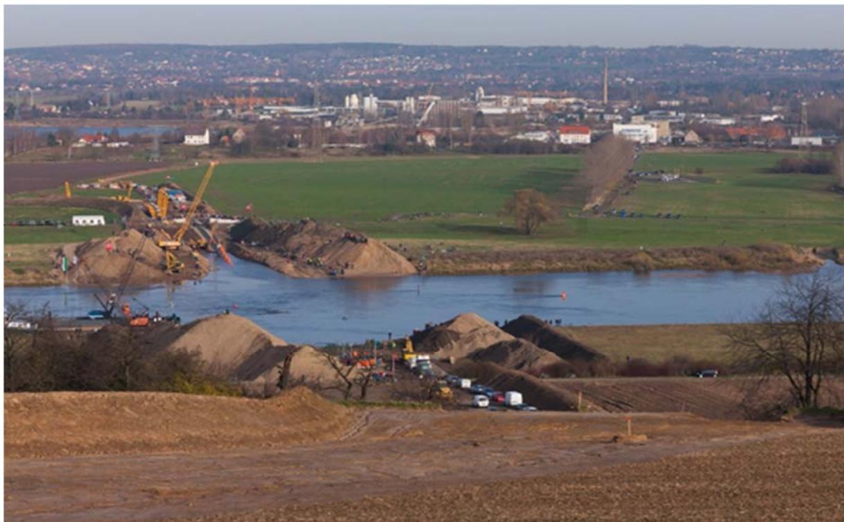
Abb. 1: Elbedüker Bau der OPAL bei Coswig
