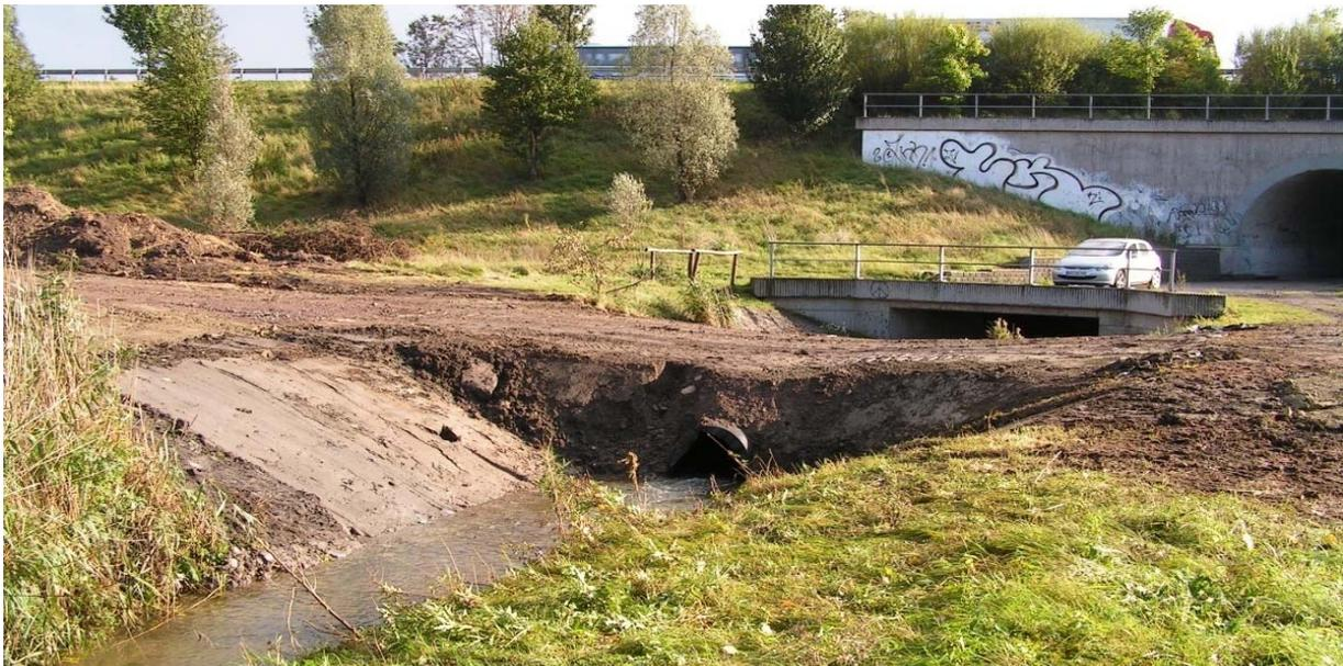
Abb. 2: Gewässerüberfahrt mittels temporärem Rohrdurchlass
