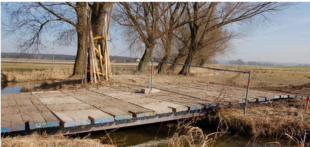
Abb. 3: Gewässerüberfahrt mittels Pionierbrücke
