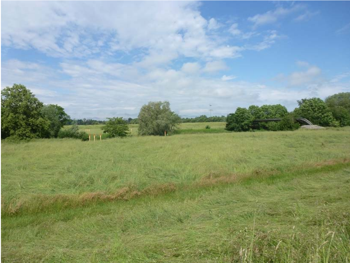
Abbildung 1: FFH-Gebiet "Elsteraue südlich Zwenkau", DE 4739-302 (Landesinterne Nr. 218): Blick Richtung Westen auf den Querungsbereich der Weißen Elster mit dem Verlauf der bereits sanierten Leitungen
