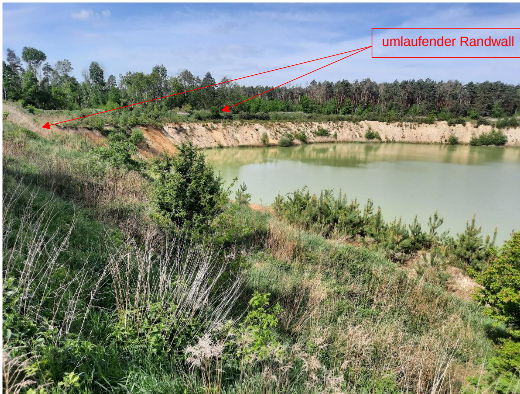
Abbildung 2: Südliche Randböschung - Blick von Böschungsoberkante nach Südwesten
