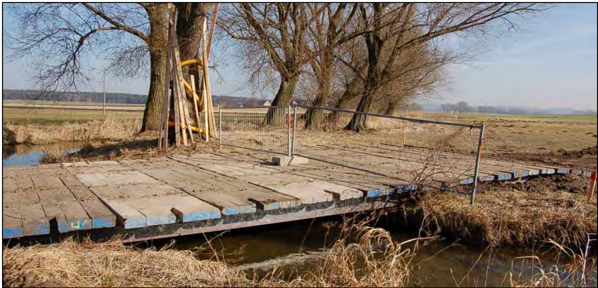
Abbildung 3: Bsp.: Gewässerüberfahrt mittels Pionierbrücke
