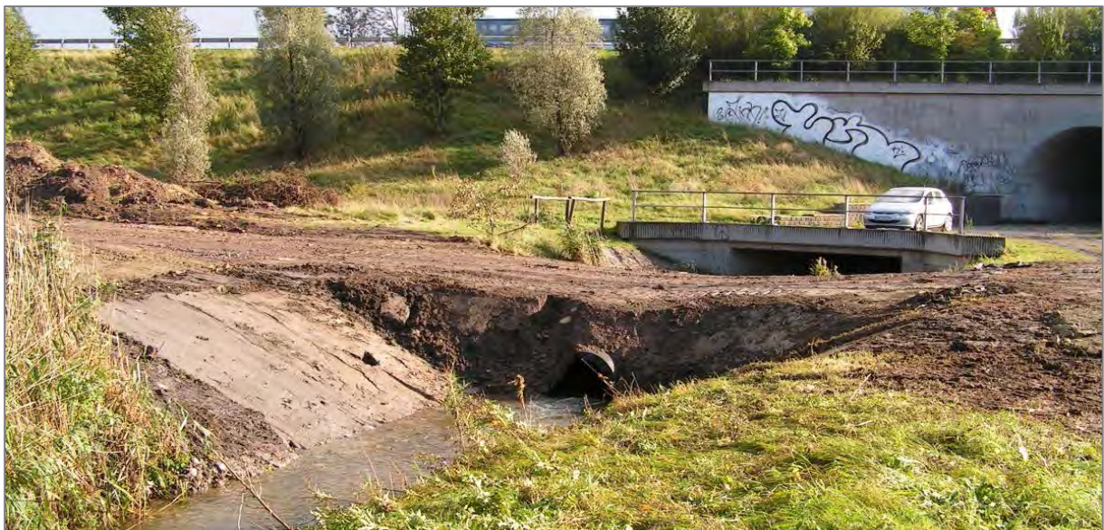
Abbildung 2: Bsp.: Gewässerüberfahrt mittels temporärem Rohrdurchlass
