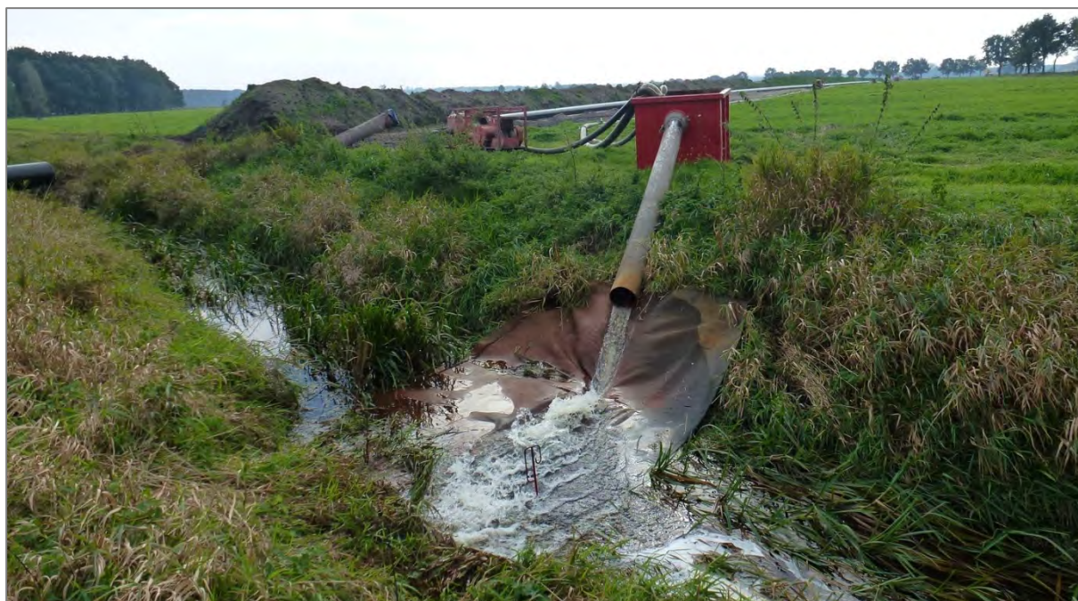
Abbildung 4: Bsp.: Einleitung des Grundwassers in Oberflächengewässer mit Schutz vor hydraulischer Belastung
