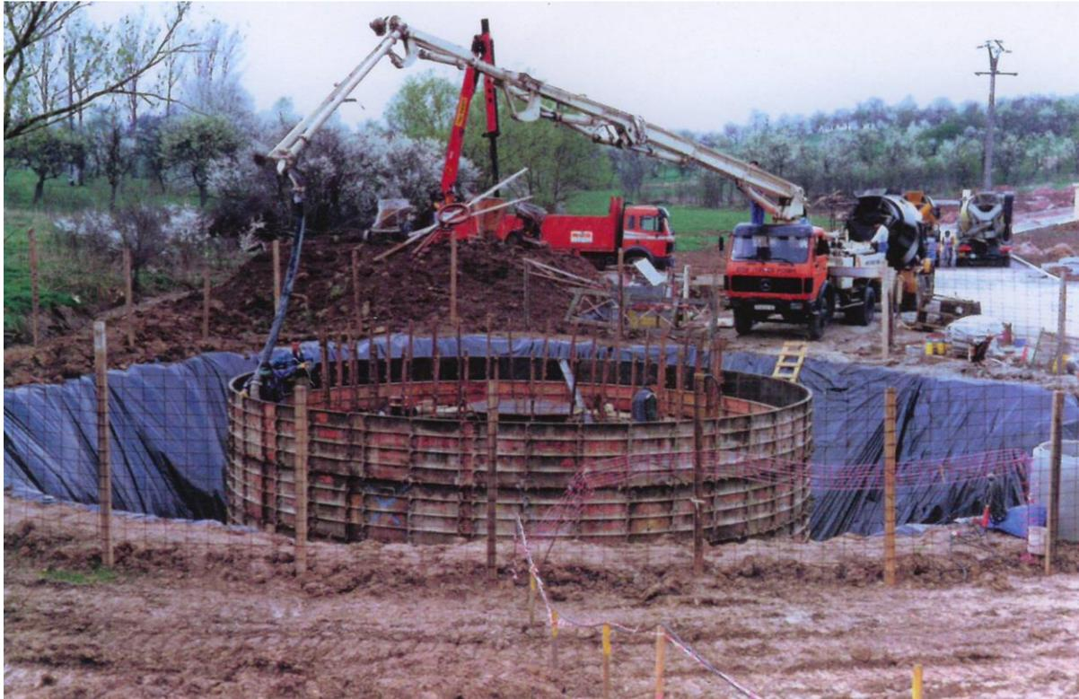
*Bétonnage à l'aide d'une pompe à béton et
