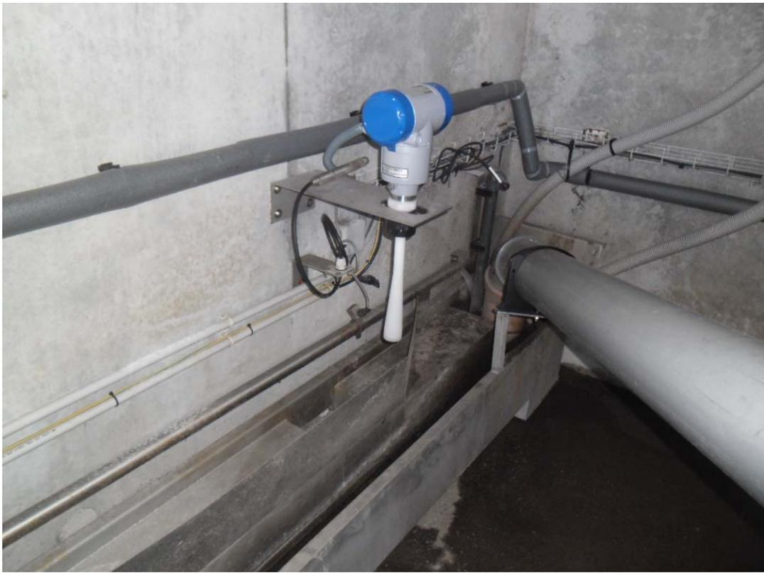
8. Canal de mesure de sortie + sonde de mesure « radar »
