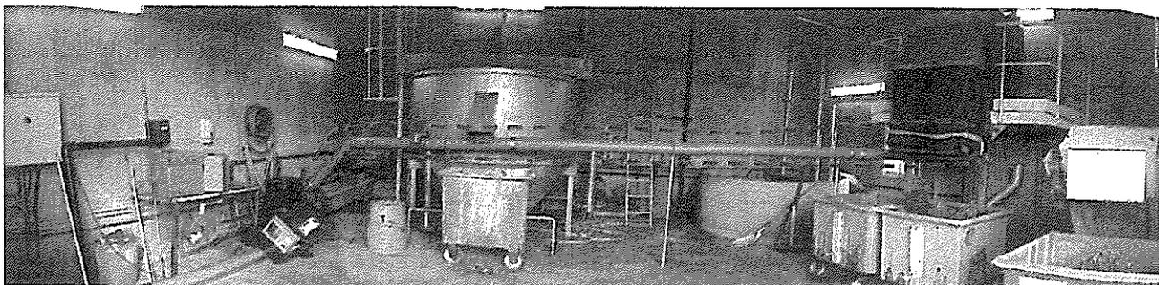
Afin de pouvoir néanmoins procéder aux mesures, un débitmètre a été installé dans l'objectif d'être utilisé en "détecteur de passage" et totalisateur de volumes, sur la base d'un débit des pompes de relevage de  $33 \text{ m}^3/\text{h}$  en moyenne, étalonné au début et au milieu de la campagne de mesures.
