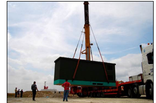
Figure 17 : Matériel spécifique de pose des locaux techniques
