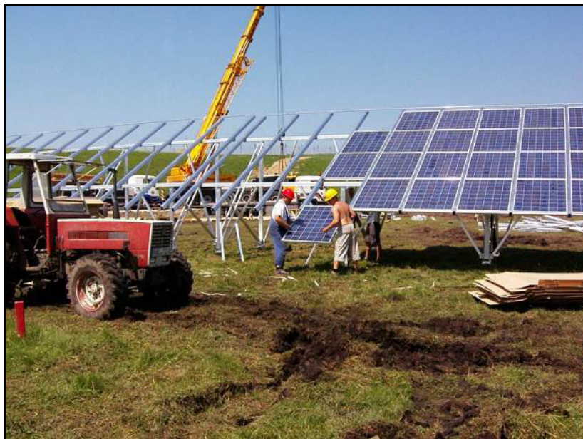
Figure 16 : Pose des panneaux
