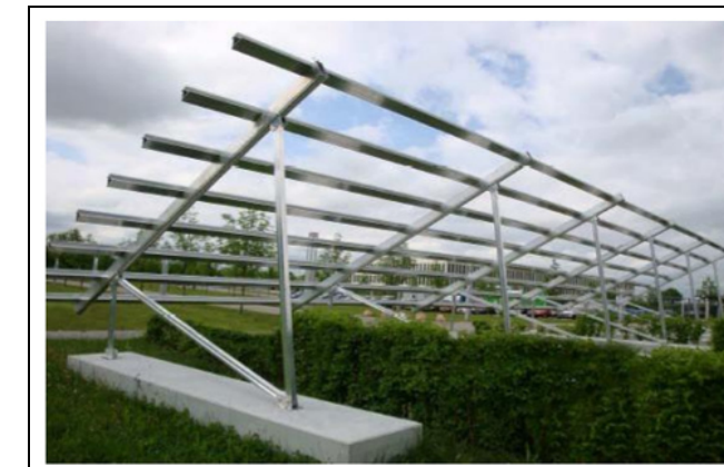
Figure 11 : Photographie d'une structure support métallique sur fondation en longrines
