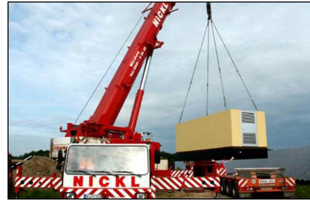
Figure 17 : Matériel spécifique de pose des locaux techniques
