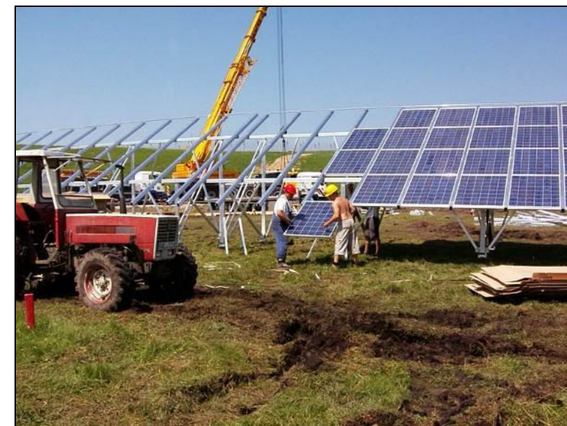
Figure 19 : Pose des panneaux
