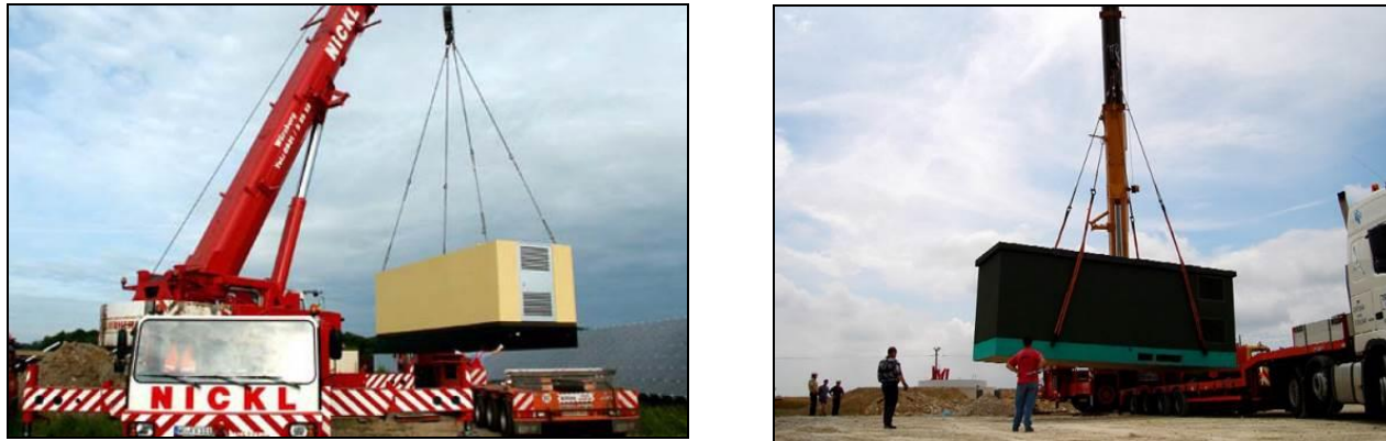
Figure 20 : Matériel spécifique de pose des locaux techniques
