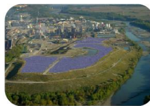
CASA (9 MW) – CRE3 En exécution
