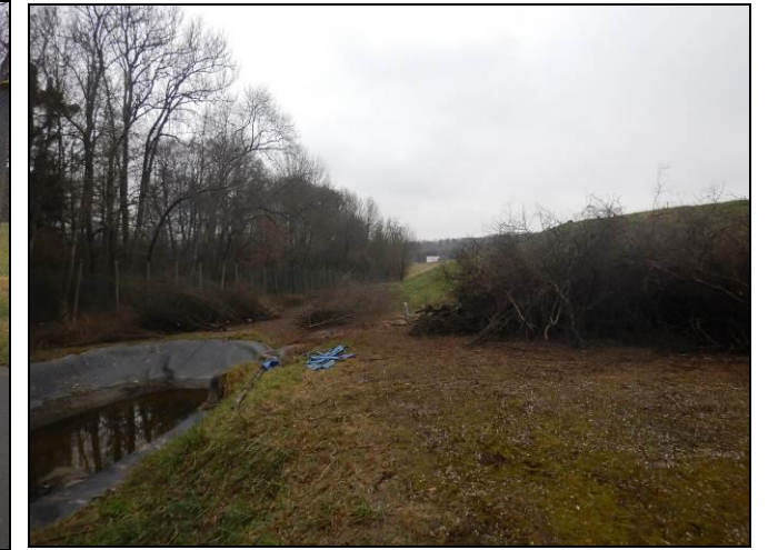
Vue 13 – Bassin de gestion des eaux pluviales du CET
