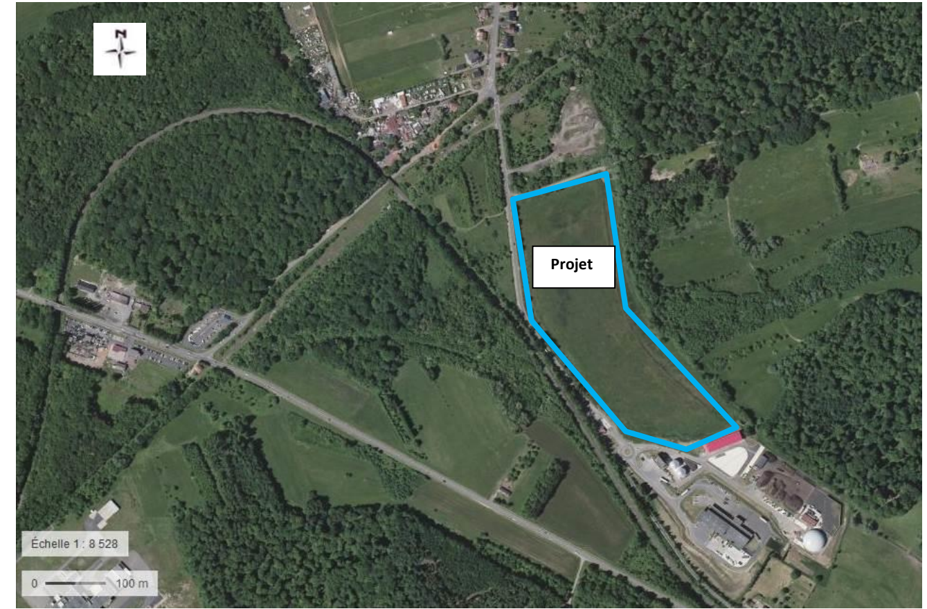
Figure 4 : Vues aériennes du site (source fond : Géoportail, prises de vue de 2015)
