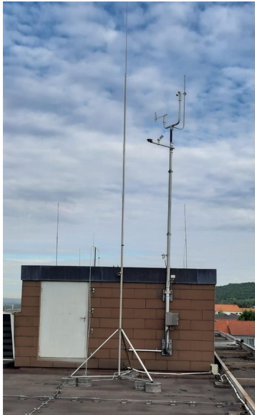
Abbildung 7-1: Ansicht der Messstation auf dem IT-Gebäude der Saarstahl AG mit Blickrichtung nach Westen
