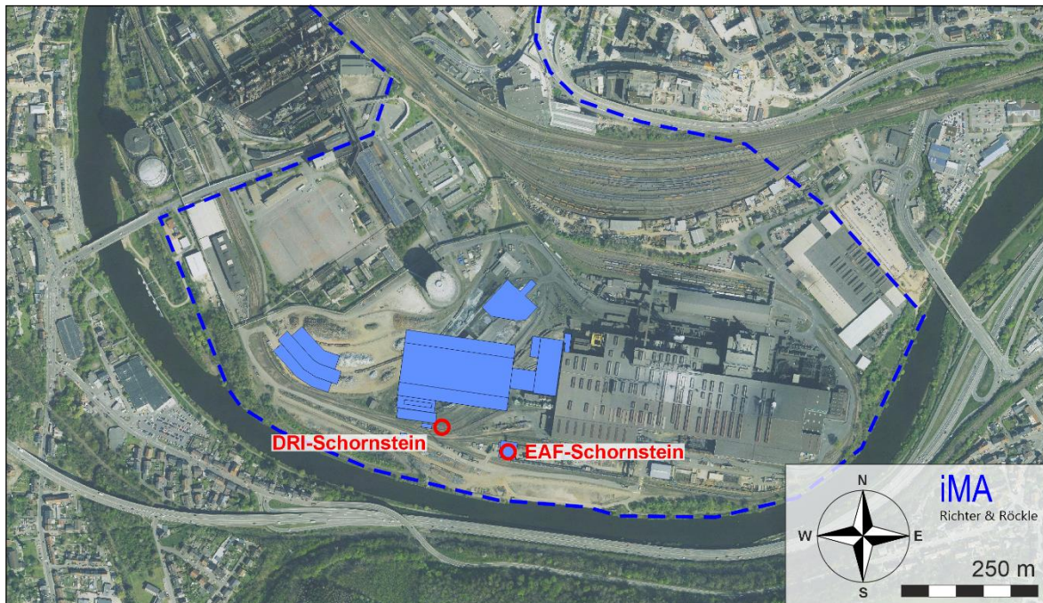
Abbildung 2-3: Betriebsgelände sowie umgebende Nutzungen im Luftbild. Luftbildgrundlage: onmaps.de © GeoBasis-DE/BKG 2023 © Hexagon.
