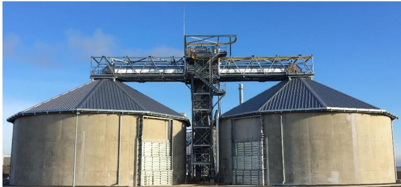
Figure 6 : Exemple de système de stockage avec alimentation par le haut
