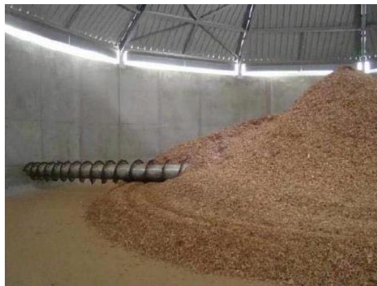
Figure 3. Vis d'extraction planétaire sous silo de stockage bois
