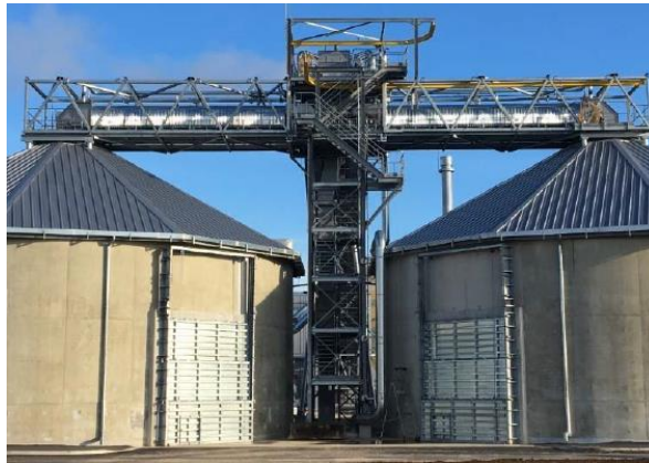
Figure 1. Stockage du bois
