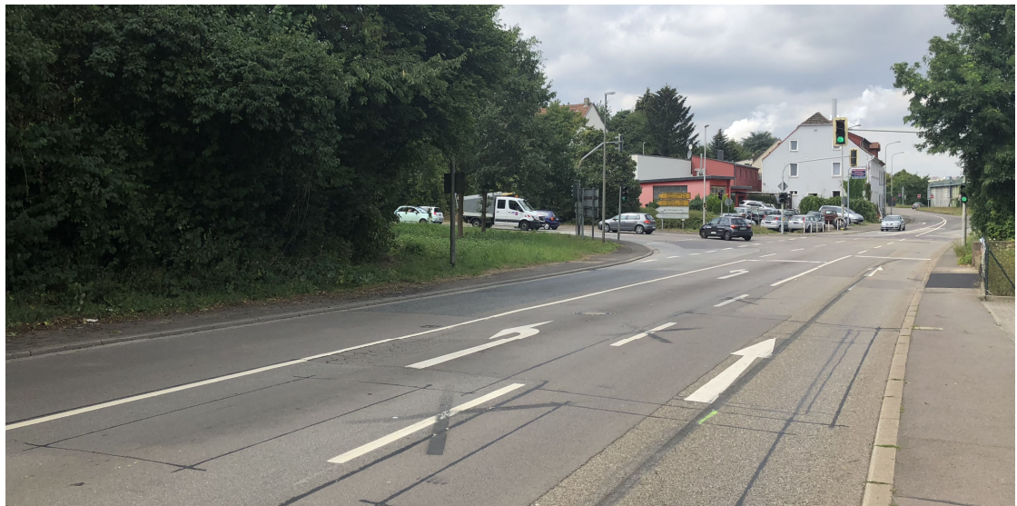
Abb. 5: Knotenpunkt L.I.O. 163 / L.II.O. 271 - Stangenmühle, in Richtung Fenne
