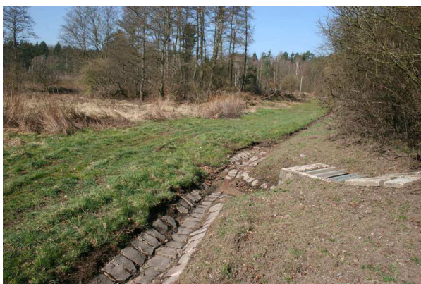
Abb.6: GB 6609-09-1009 (Nassbrache) im Bereich des Speckenbaches; unteres Bild: Mündung des bestehenden Durchlasses in ausgepflasterte Entwässerungsrinne. Hier endet die geplante Böschung, links angrenzend wird der Unterhaltungstreifen angelegt.
