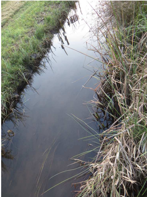
Abb. 3: Mutterbach kurz vor dem A 8 Durchlass. Dieses nahezu stehende Gewässer mit versandeter-verschlammter Bachsohle ist mit Sicherheit kein Wasseramsel-Gewässer. Alle anderen Gewässer im Betrachtungs- bzw. Eingriffsbereich sind morphologisch noch schlechter strukturiert.
