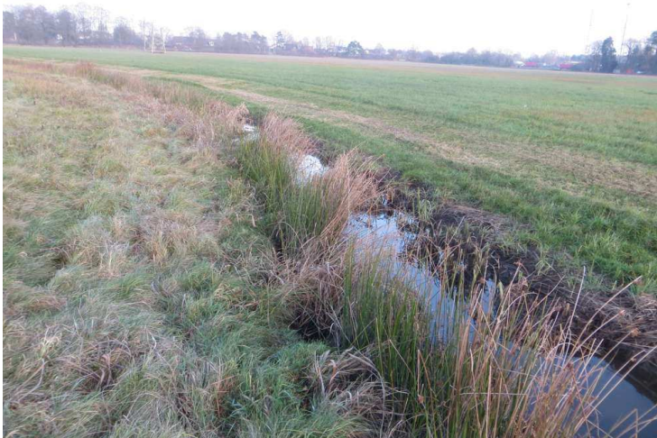
Abb.7: GB 6609-09-2018, rudimentärer Gewässersaum entlang des Mutterbaches
