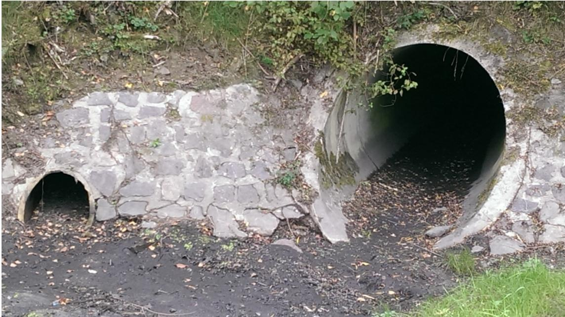
**Abbildung 7: Durchlass Erlenbrunnenbach DN 1600 und vorh. Zulauf DN 500 der Rampenentwässerung(wird erneuert)**
