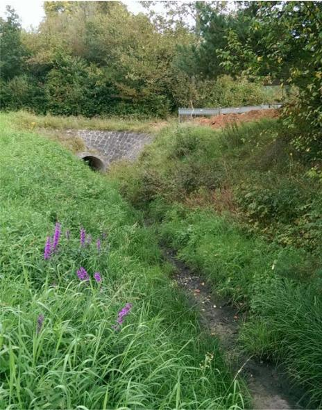
**Abbildung 9: Erlenbrunnenbach und Durchlass DN 1400 zur vorh. Abscheideranlage**
