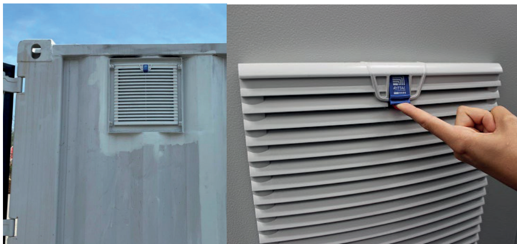
Abbildung 12: Filtergitter für die Luftzufuhr zum Seitenkanalgebläse
