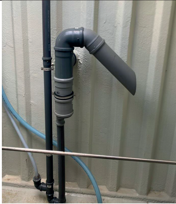
Abbildung 5: Klarwasserabzugsvorrichtung (fixierter Dekanter mit Rückspülung))
