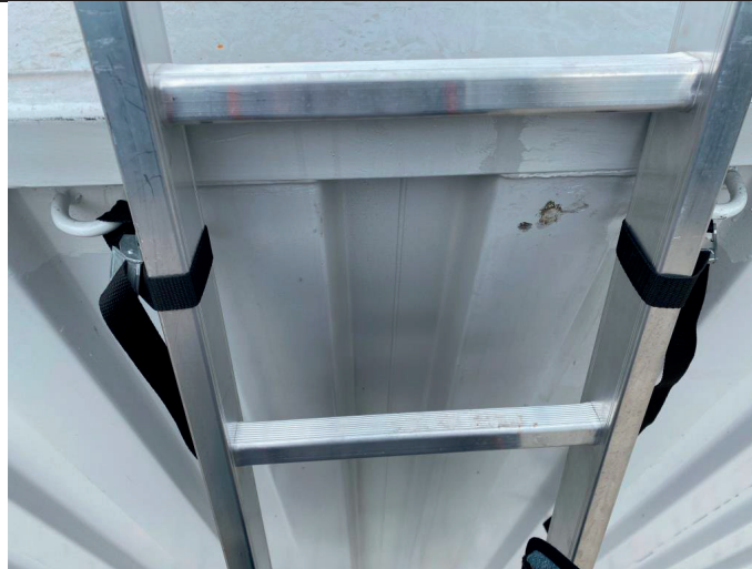
Abbildung 11: Leiter auf der Rückseite des Containers Laschen an Ösen
