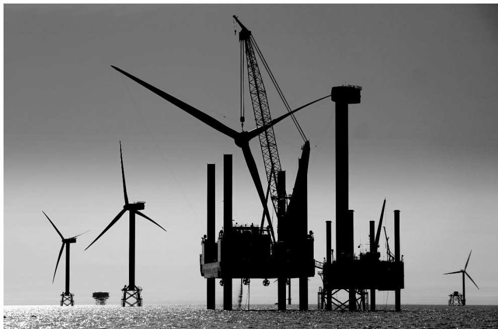
Abbildung 3-13 Installation einer Windenergieanlage mittels Installationsfahrzeug mit Hubinsel.
