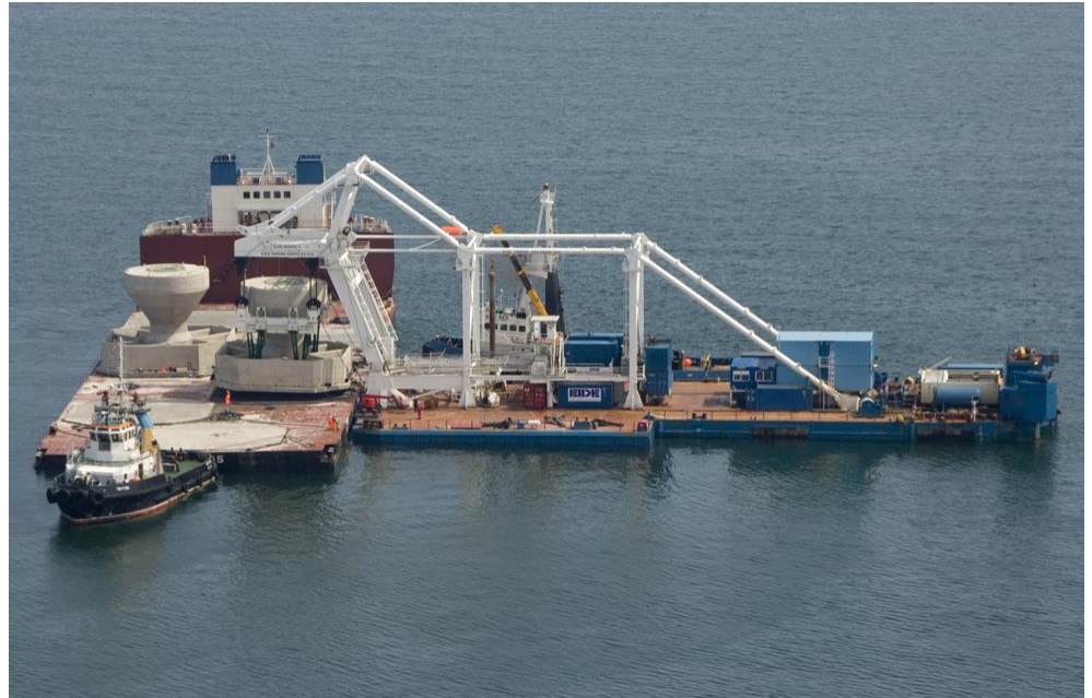
Abbildung 3-11 Beispiel für den Transport und die Installation von Windenergieanlagenfundamenten, in diesem Fall Schwergewichtsfundamenten.
