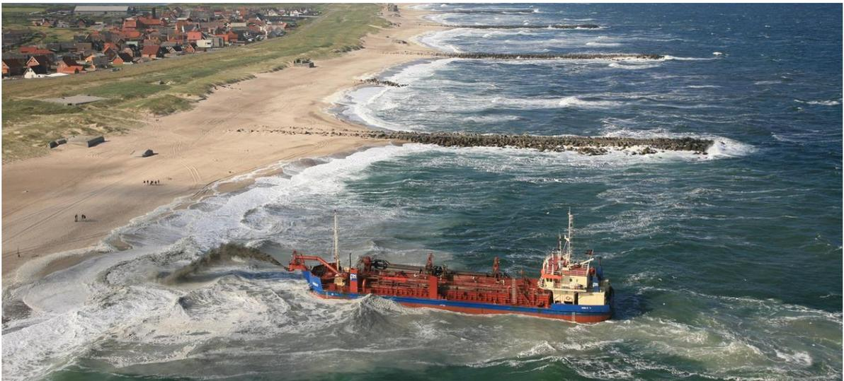
**Abb. 4:** Einbringung von Sand in den Vorstrand-/Strandbereich durch einen Hopperbagger mittels Rainbow-Verfahren. Foto: KYSTDIREKTORATET (2012), Strandaufspülung Westküste Dänemark
