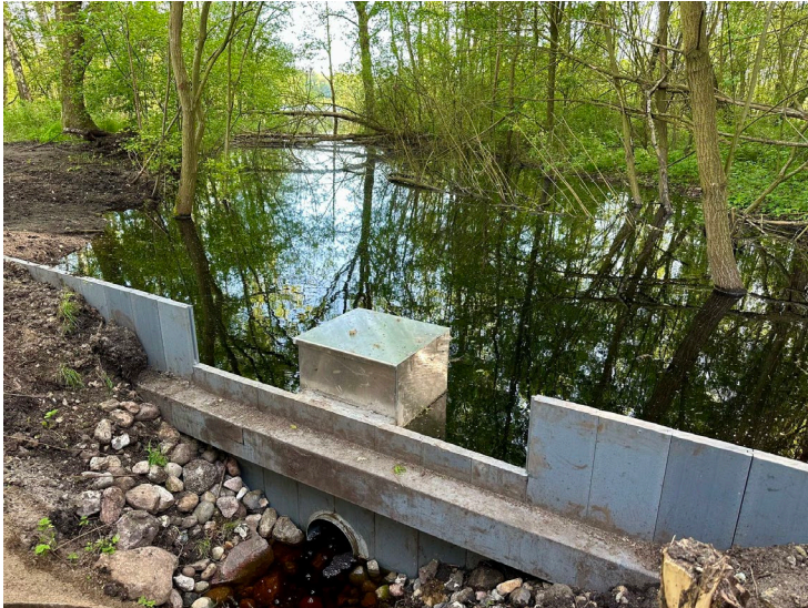
Abb. 3: Wehr zur Tensfelder Au im Tarbeker Moor (Quelle: komoot.com)
