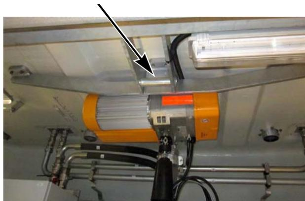
Abb. 18 Personenanschlagpunkt an der Tragstruktur
