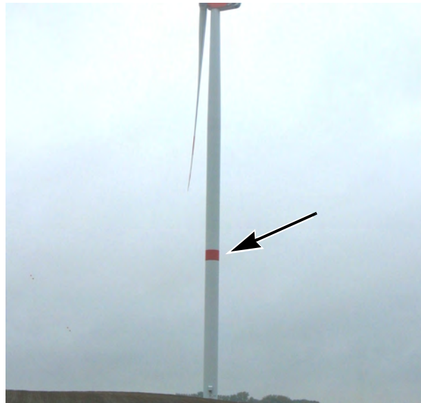
Abb. 7 Roter Farbring an Anlage mit Gesamthöhe >150 m
