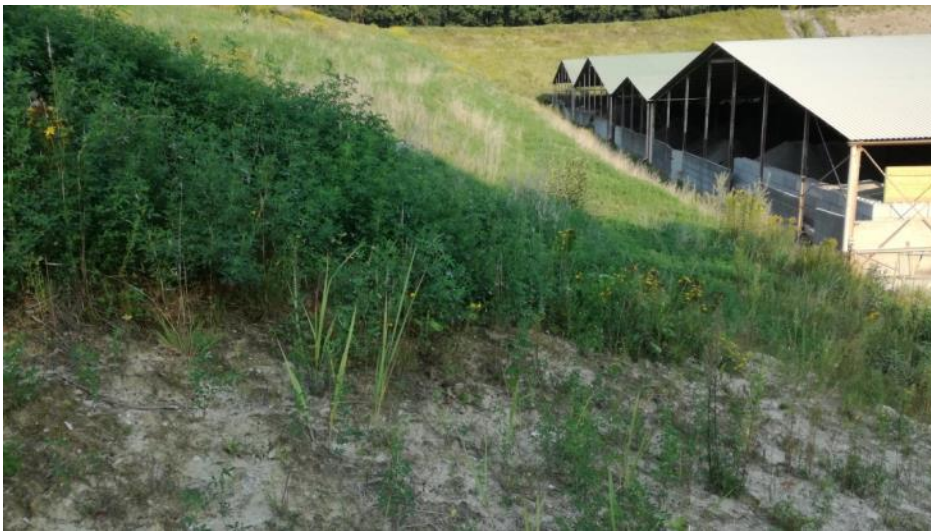
Foto 15: Mittlerer und unterer Böschungsabschnitt im August 2019
