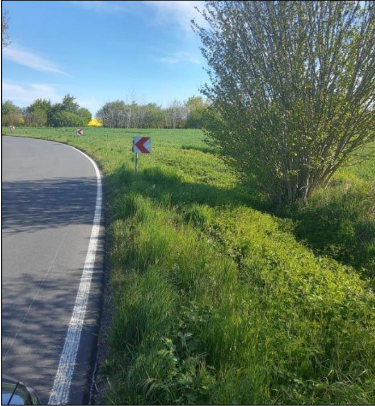
Bereich Knickauffüllung Nr. 3
