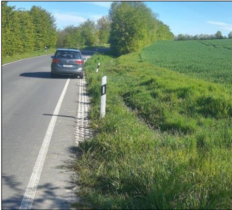
Bereich Knickauffüllung Nr. 1
