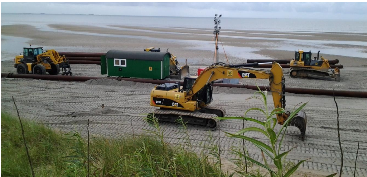
Abb. 3: Beispielhafte Darstellung einer Baustelleneinrichtung im Aufspülbereich Quelle Foto: LKN.SH
