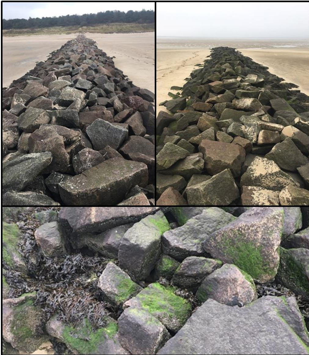
Abb. 11: Steinschüttbuhne im Eulitoral des Spülabschnitts II. Fotos: BioConsult, Begehung November 2020
