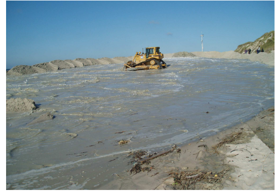
Abb. 37: Spülfeld mit Spül-/Leitdamm
