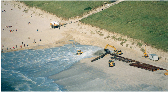
Abb. 36: Strandaufspülung mit küstenparalleler Rohrleitung und offenem Spülfeld
