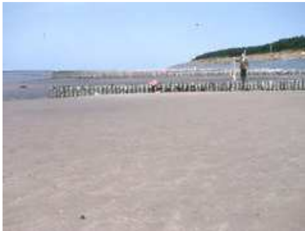
Abb. 15 - Holzbuhnen vor der Kurklinik (vor dem Bau der Schüttsteinbuhnen)
