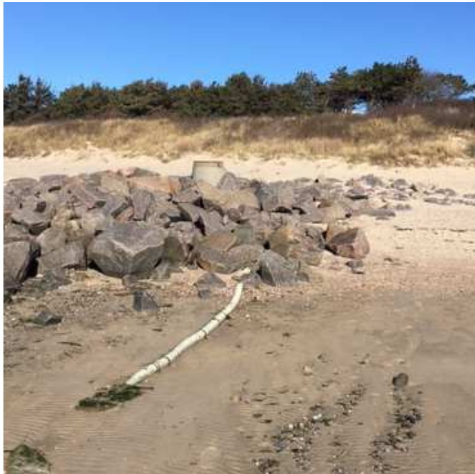
Abb. 26 – Bade- und Regenwasserableiter mit Übergabeschacht
