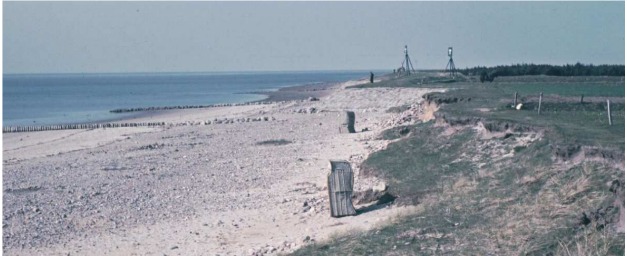
Abb. 5 – Übergang Landesschutzdeich - Weststrand Utersum (1976), Blickrichtung Norden
