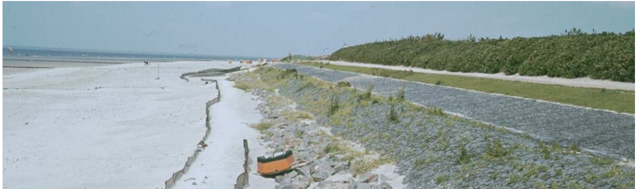
Abb. 11 – Bastdeckwerk Südwestspitze Utersum (1977), Blickrichtung Norden
