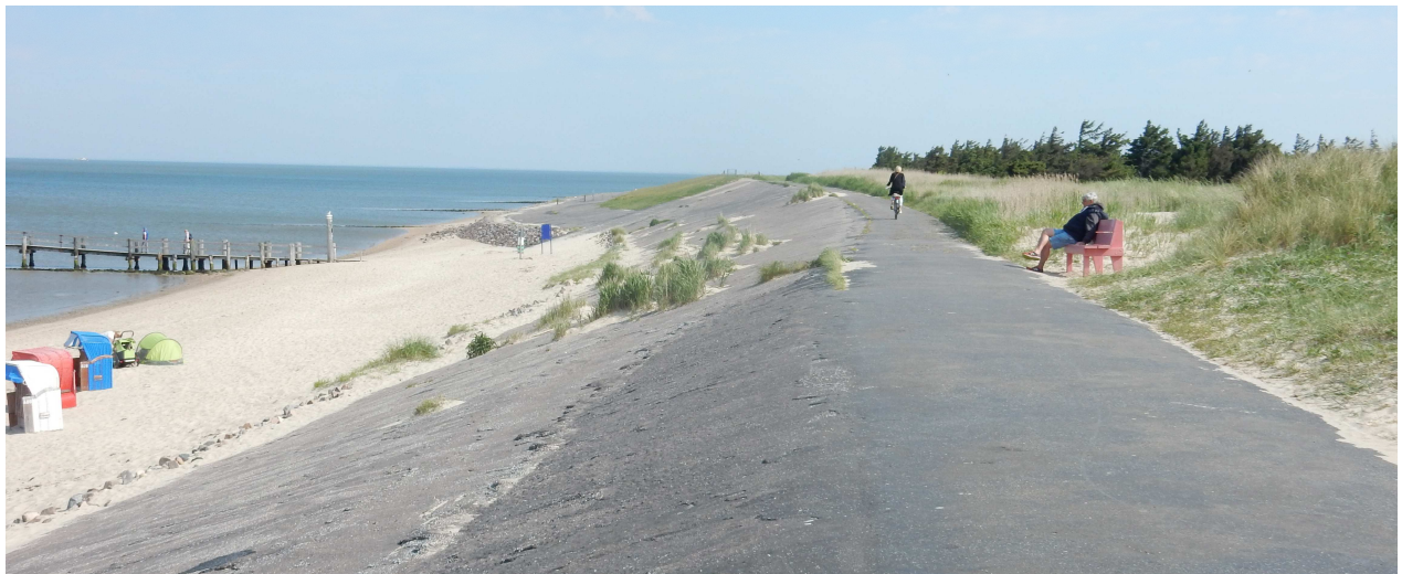
Abb. 6 – Übergang Landesschutzdeich - Weststrand Utersum (2021), Blickrichtung Norden
