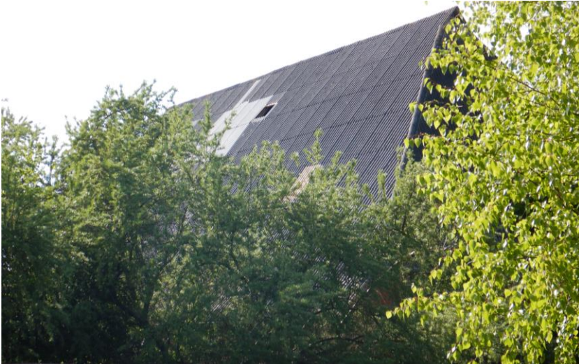
Abbildung 21: Bauernhaus in Harmswörden (Gebäude-Nr. 1) – Dach der Scheune
