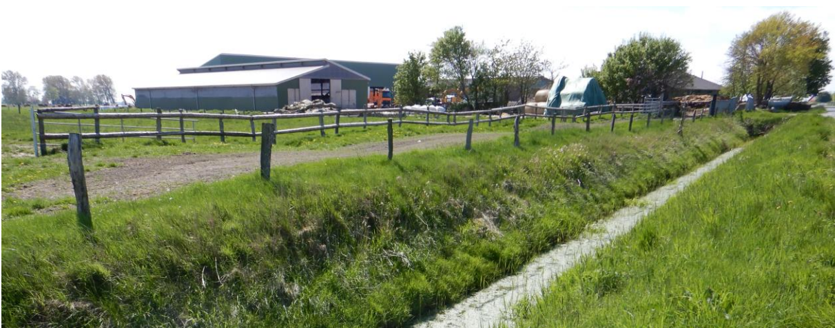
Abbildung 23: Scheunen Kanzlei (Gebäude-Komplex Nr. 3)
