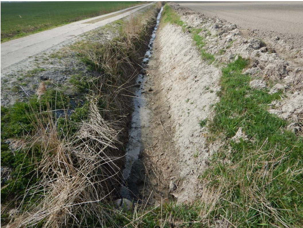
Abbildung 4: Graben entlang des Weges Barsfleth
