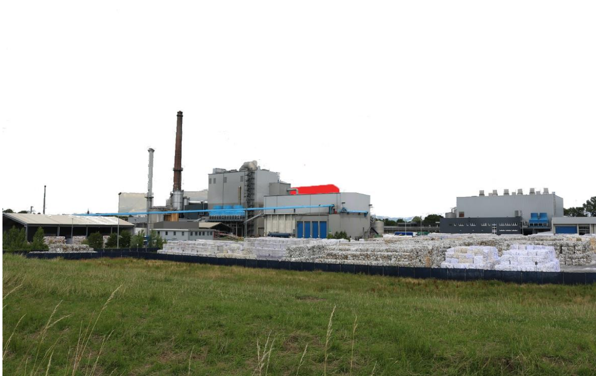
Abbildung 2-7 Blick auf das Anlagengelände STP mit modelliertem Kessel 7 (rot) vom alten Deich aus (Südwest)
