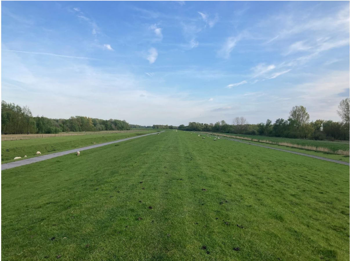
Abbildung 10 Deich zwischen Fläche (2) und (4)
