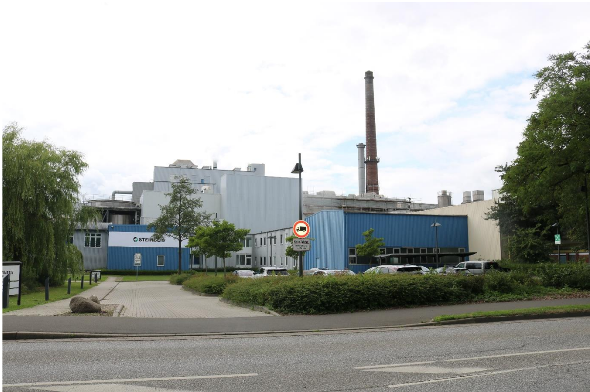
Abbildung 2-4 Blick auf das Anlagengelände STP ohne Kessel 7 von der Stadtstraße aus (Osten)
