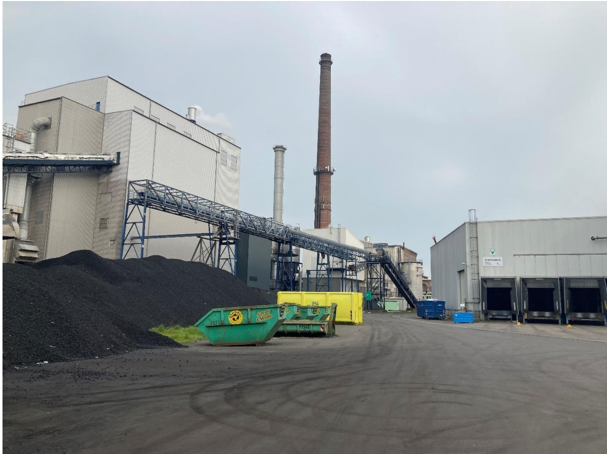
Abbildung 11 Vorhabenstandort Kessel 7 auf dem Steinbeis Energie GmbH – Gelände
