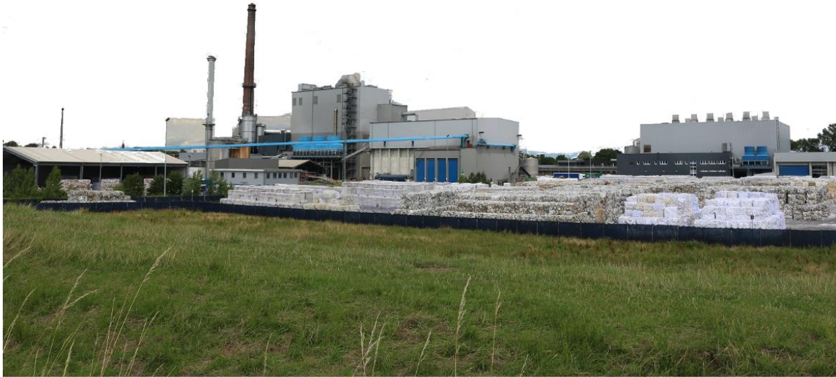
Abbildung 2-6 Blick auf das Anlagengelände STP ohne Kessel 7 vom alten Deich aus (Südwest)
