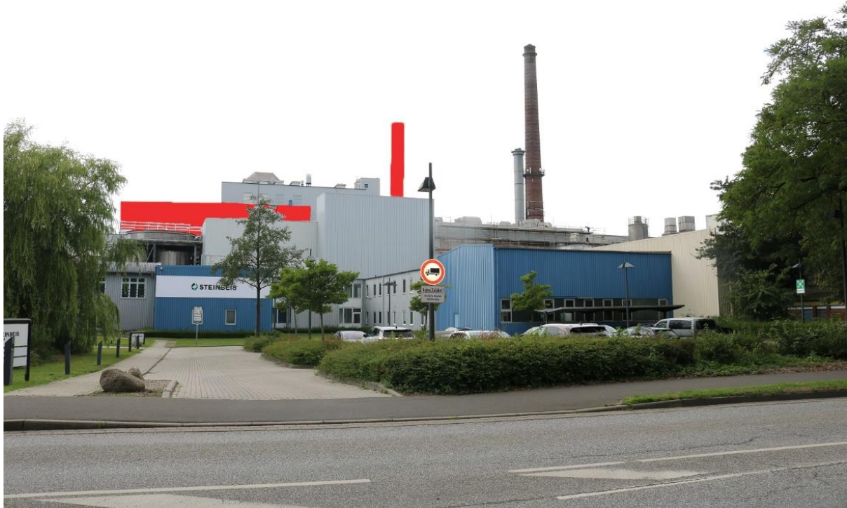
Abbildung 2-5 Blick auf das Anlagengelände STP mit modelliertem Kessel 7 (rot) von der Stadtstraße aus (Osten)
