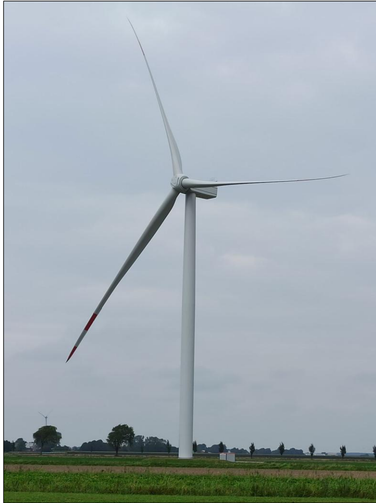
Abb. 3.2.2.: Nordex N133 mit 149,1 m Gesamthöhe
