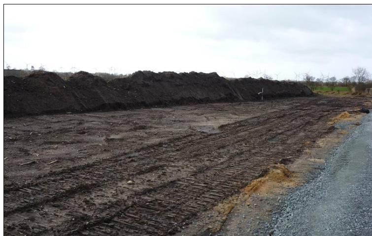
Abb. 4.4.3: Mutterboden muss sorgsam abgetragen und nicht zu hoch aufgetürmt (&lt; 2 m) aufbewahrt werden
