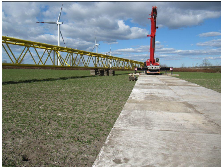
Abb. 3.2.4: Episodisch ausgelegte Bodenplatten für Montagearbeiten am Kran
