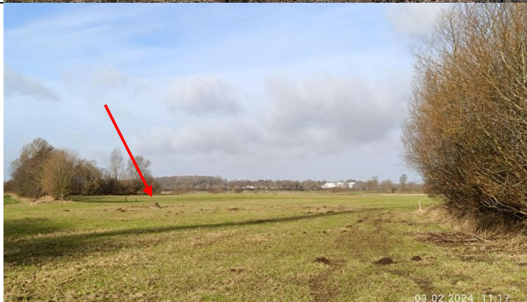
Schacht mitten auf dem Flurstück
