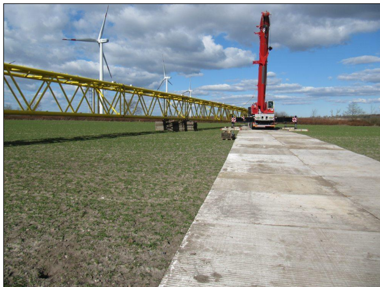
Abb. 1.3.5: Episodisch ausgelegte Bodenplatten für Montagearbeiten am Kran
