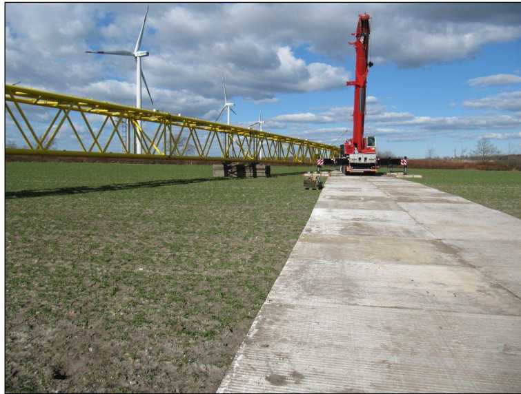
Abb. 1.3.5: Episodisch ausgelegte Bodenplatten für Montagearbeiten am Kran
