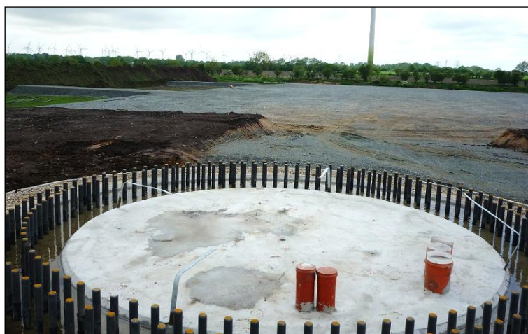
Abb. 5.1.2: Beispiel von Fundament und Kranstellfläche
