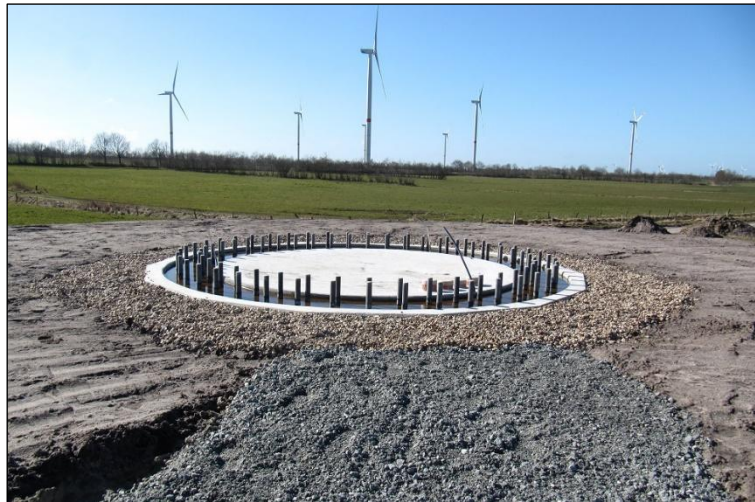
Abb. 1.3.5: Episodisch ausgelegte Bodenplatten für Montagearbeiten am Kran
