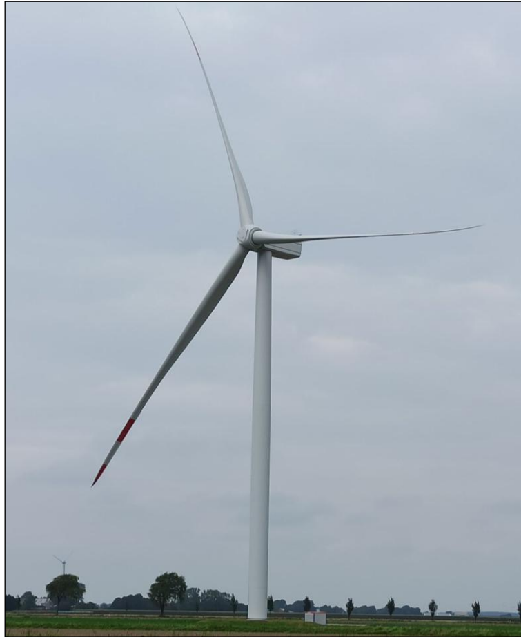
Abb. 1.3.3: Nordex N133 mit 149,1 m Gesamthöhe
