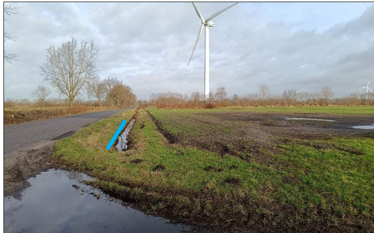
Abb. 4.5.5: Betroffener Graben am Standort RA05
