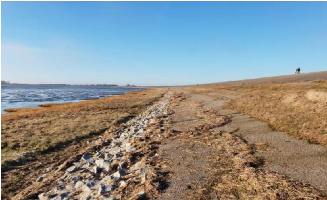
Abbildung 3 **Deichfuß mit Treibsel auf dem Asphaltdeich, vollverklammerte Steinschüttung und Salzwiesensaum unterhalb des Deiches**
