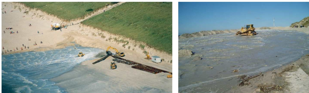
Abbildung 3.12: links Strandaufspülung mit offenem Spülfeld, rechts Strandaufspülung mit Spül-/ Leitdamm (Foto: LKN.SH)
