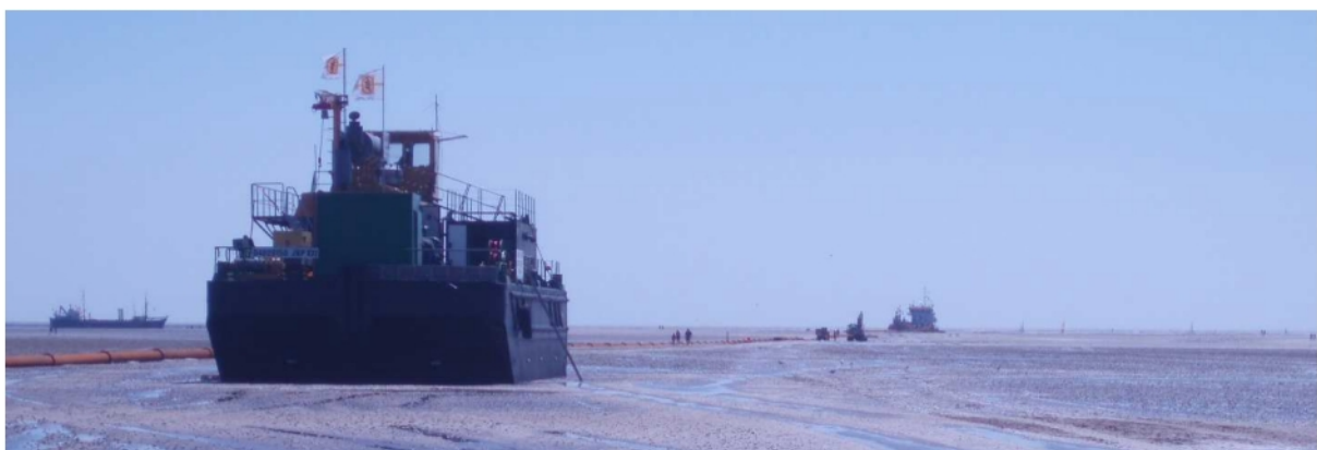
Abbildung 3.9: Druckerhöhungsstation im Watt (Foto: LKN.SH)
