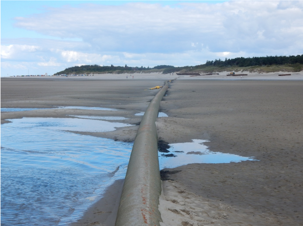
Abbildung 3.7: Beispiel für eine im Watt verlegte Spülrohrleitung (Foto: D.Tams, LKN.SH, Sandaufspülung Utersum 2022)
