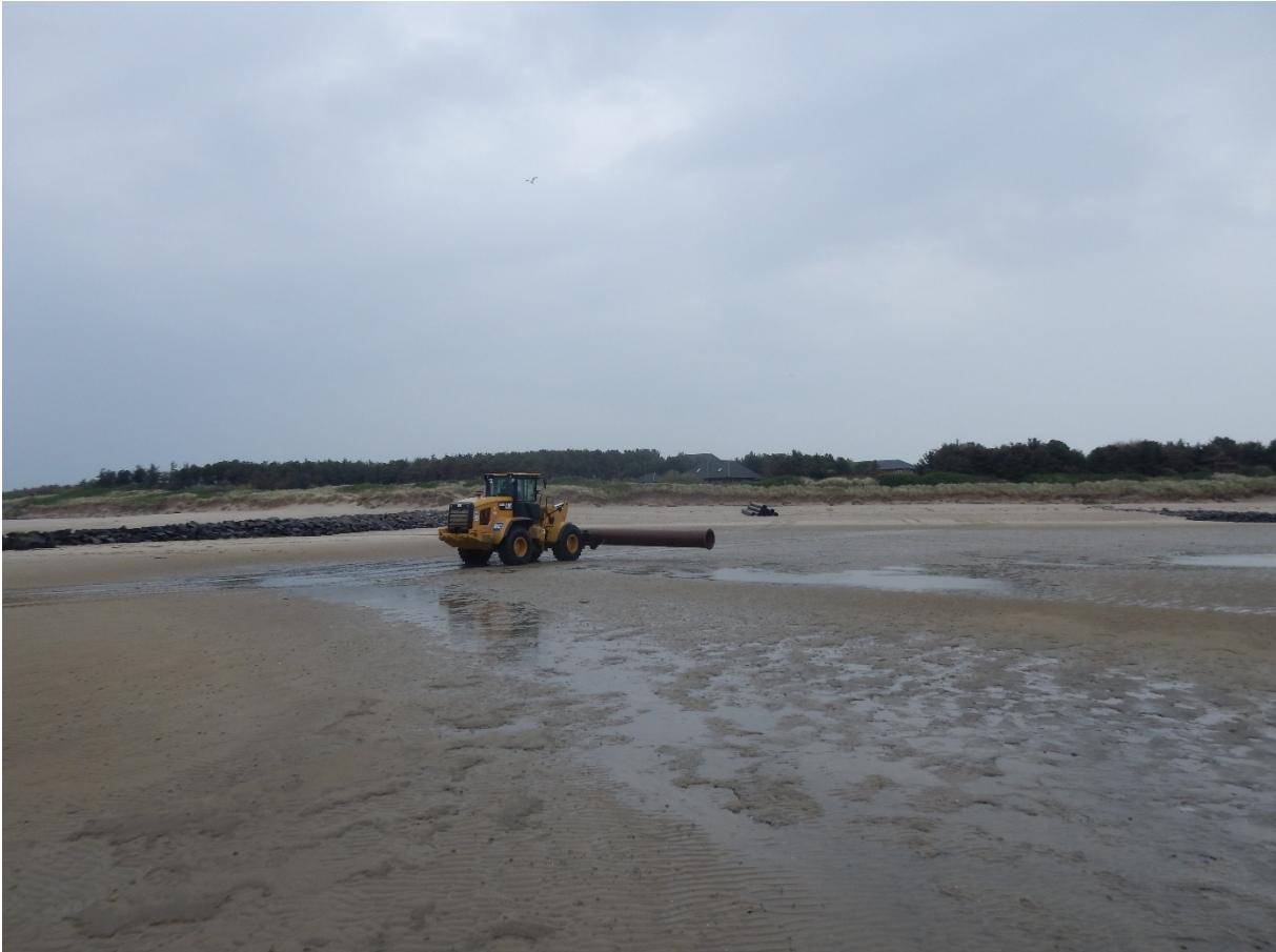
Abbildung 3.8: Beispiel für die Montagearbeiten bei Verlegung einer Spülrohrleitung am Strand bzw. im vorgelagerten Wattbereich (Foto: D.Tams, LKN.SH, Sandaufspülung Utersum 2022)
