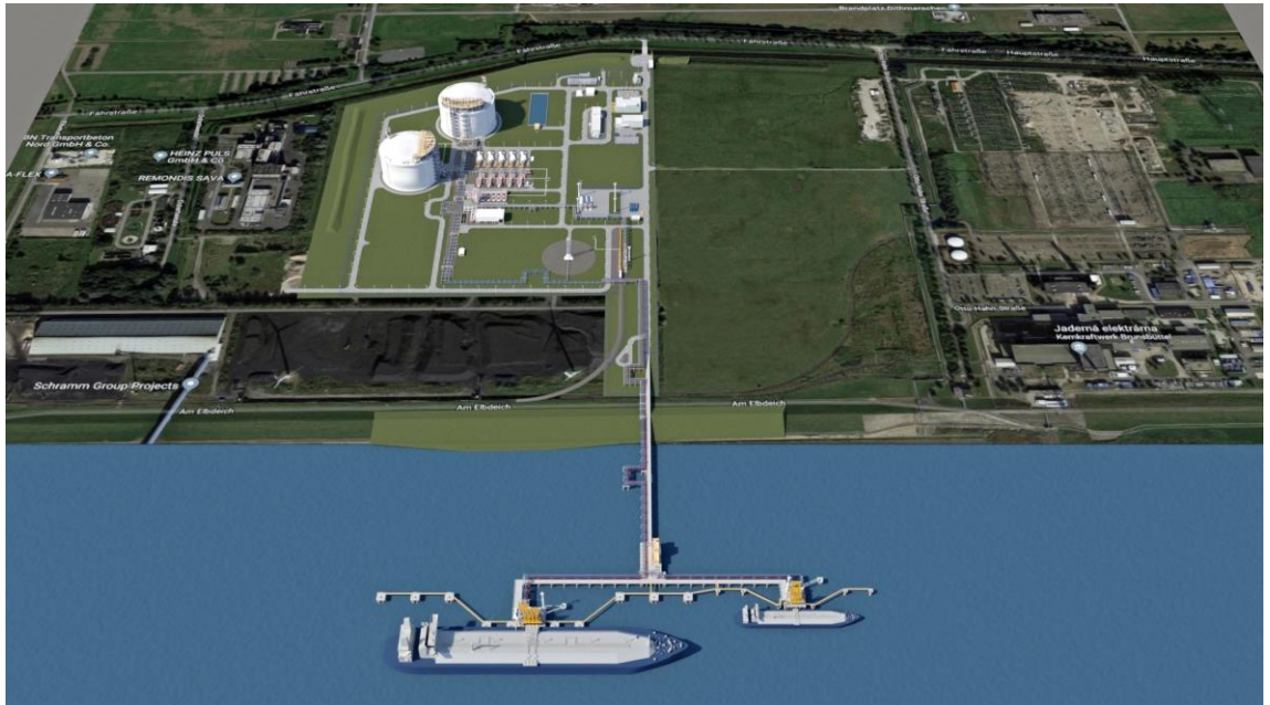
Abbildung 3-8: Jetty 1 (links) und Jetty 2 (rechts)
