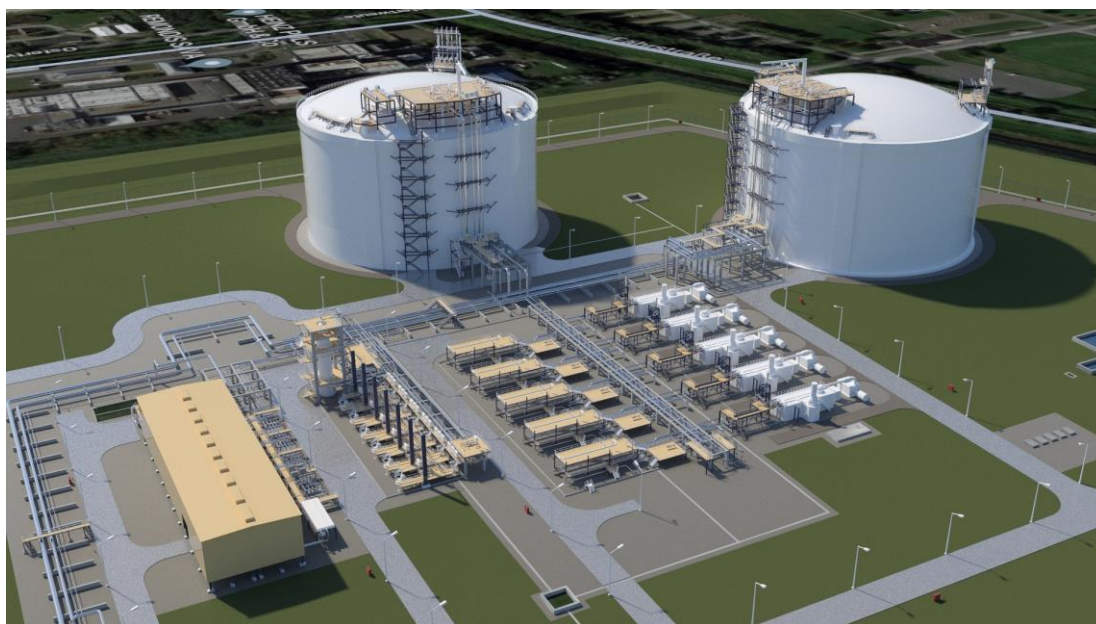
Abbildung 3-1: Lagertank T 211 und T 212
