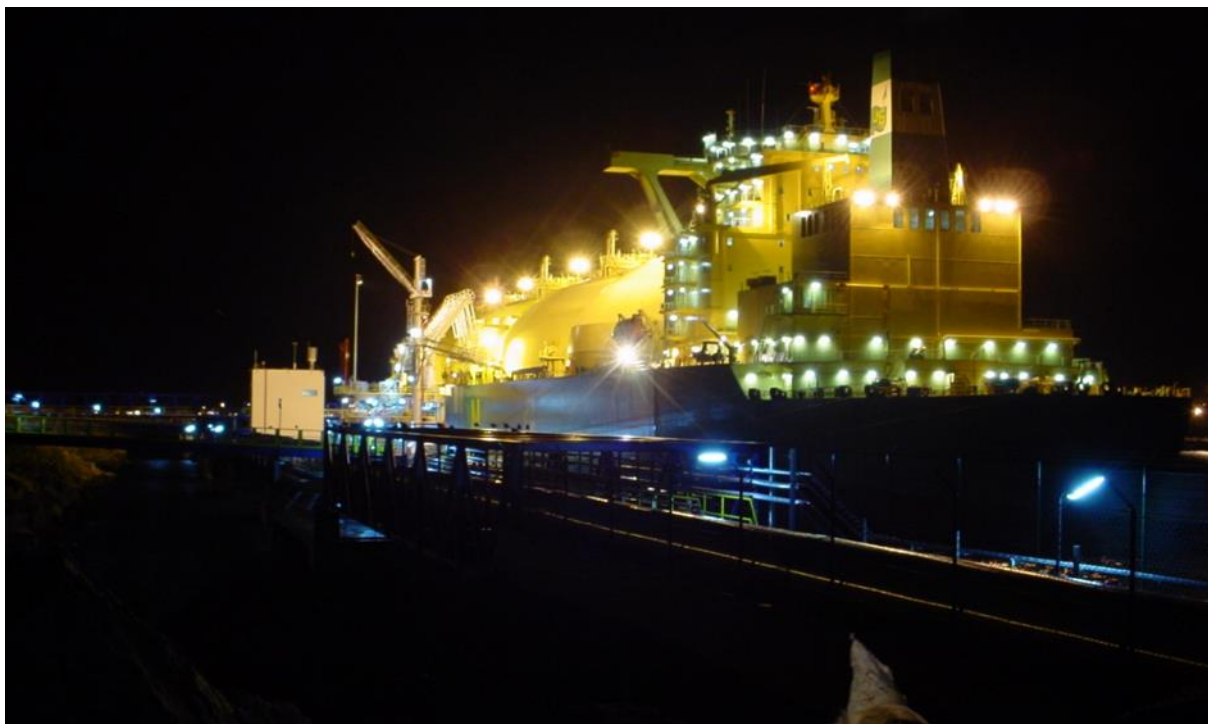
Abbildung 3: Beleuchtung LNG-Terminal im Dunkeln (exemplarisch), Blick auf das Schiffsheck
