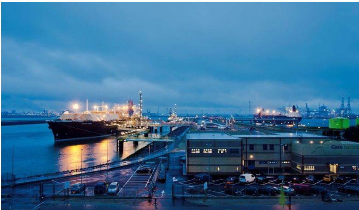
Abbildung 2: Beleuchtung LNG-Terminal bei Dämmerung (exemplarisch), Blick von Weitem
