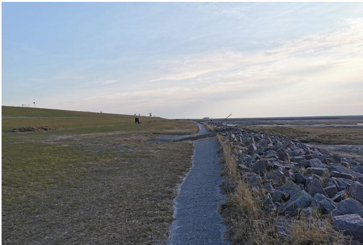
Abbildung 6 Unterer Deichbereich mit Deckwerk und Wellenüberschlagsicherung
