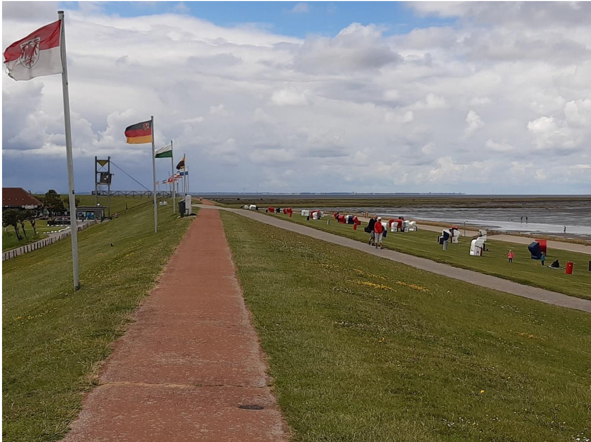
Abbildung 4 Deich vor dem Ortszentrum
