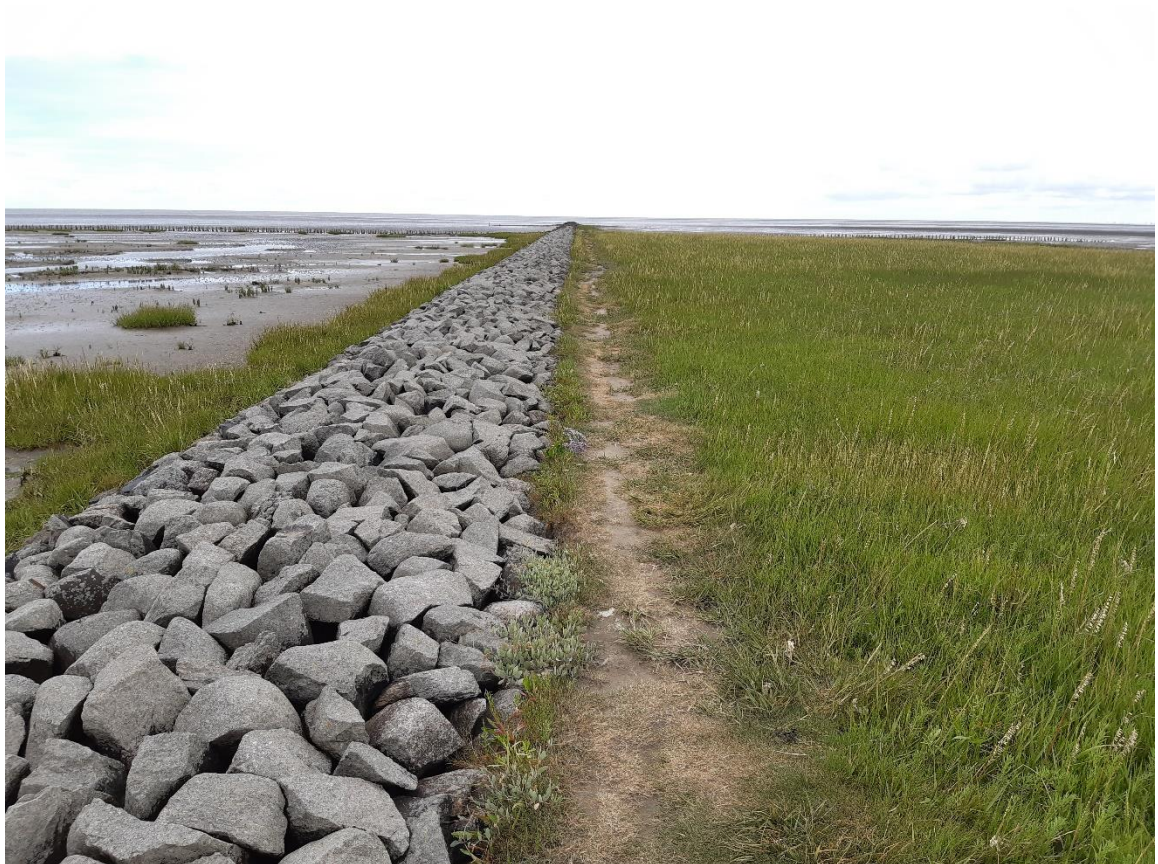
Abbildung 6 Buhne und Vorlandbereich im Bereich Friedrichskoog-Spitze
