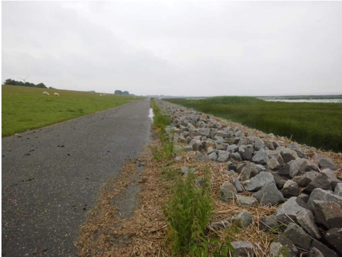
Abbildung 35 Deichverteidigungsweg außendeichs mit Steinschüttung und Brackwasser-Röhrichten (rechts außen)
