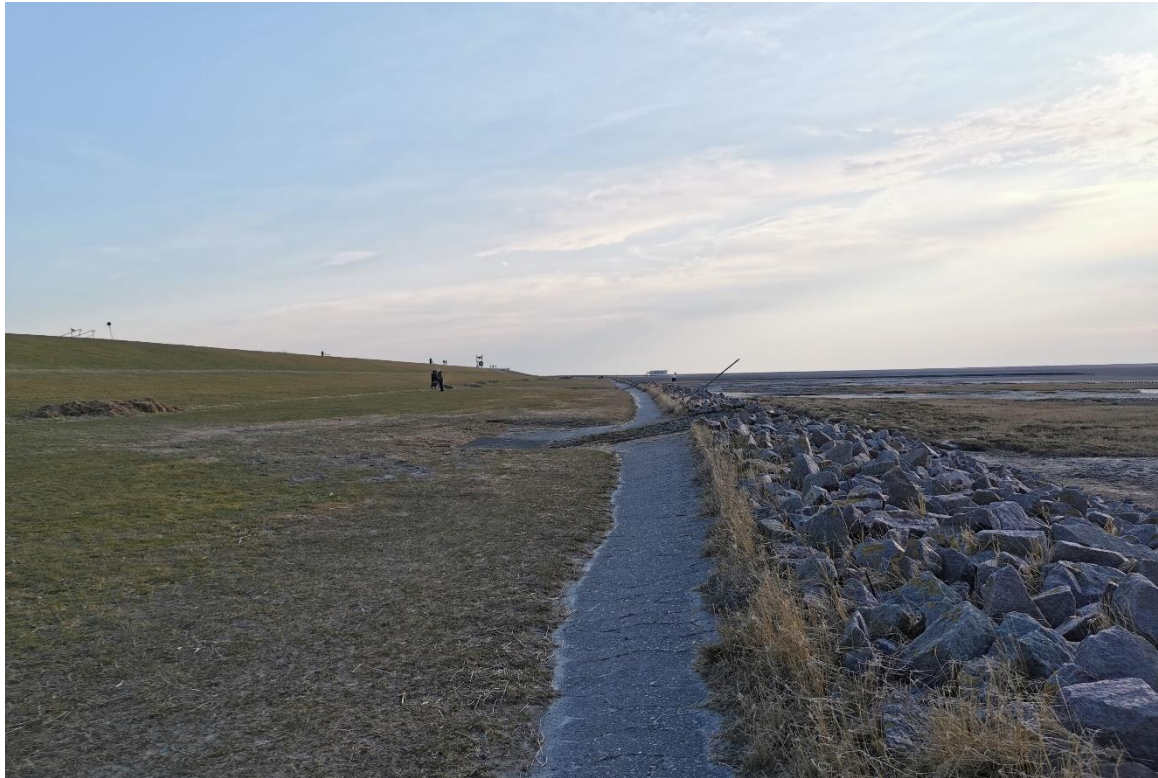
Abbildung 5 Unterer Deichbereich mit Deckwerk und Wellenüberschlagsicherung
